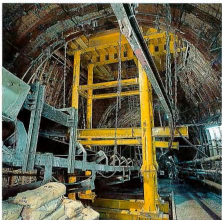
Verlagerungskonstruktion für Vibrationsrinnen
