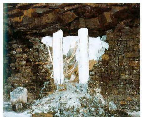
Sicherung des Kammerzugangs mit Bullflex-Pfeilern und Bullflex-Kissen
