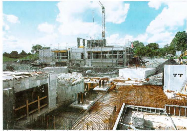
Rohbauarbeiten, im Vordergrund die Flachgründung der Schachthale mit zwei Fundamenten für das Schachtgerüst, links der im I bertäg gen Bereich abgebrochene Schacht Lerche
