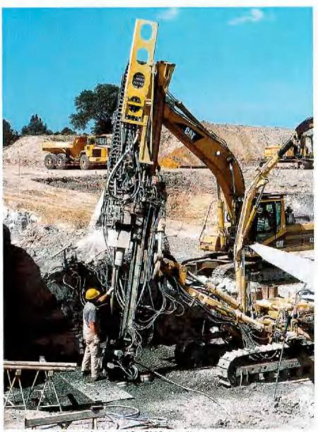
Herstellung der GEWI-Pfähle mit speziellen Pfahlbohrgeräten
