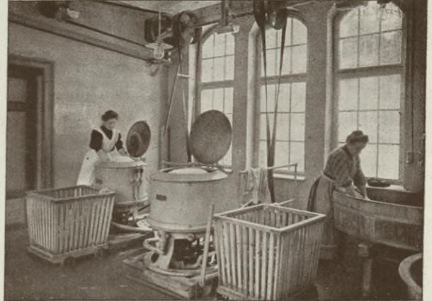
Abb. 66. Zentrifugen in der Dampf-wäscherei.
