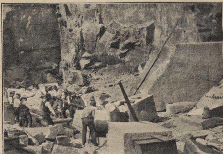
Fig. 25. Sandsteinbruch. Die Abbildung zeigt rechts eine Reihe eiserne Keile und einen abgekeilten Block; mitten und links im Vordergrund den Transport mittelst Holzwalzen.
