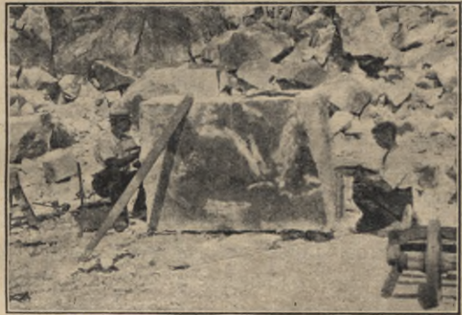
Fig. 28. Bearbeitung des Sandsteins mit dem Zweispitz.
