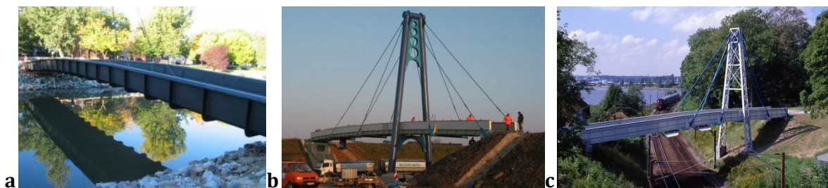
Abb. 3-17: a) CFK-Balkenbrücke in Madrid [99] . b) Stahl-GFK-Hybridbrücke bei Schwerin [100] . c) GFK-Brücke in Kolding [101]
