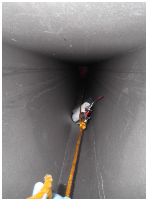
Abb. 6-11: Einziehen der getränkten Fasern
