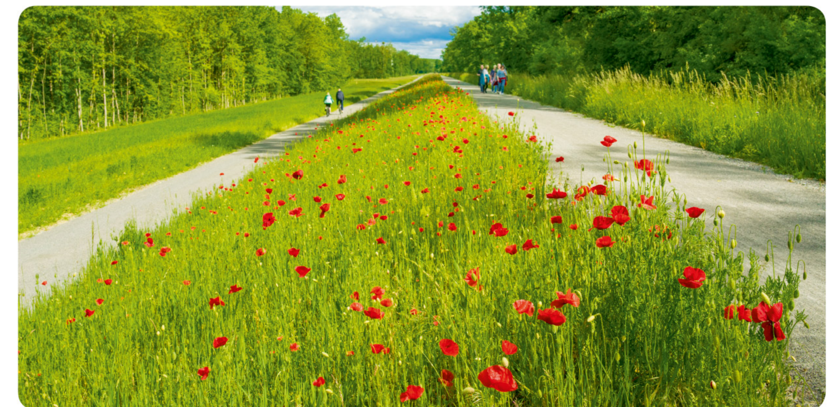
Abbildung: Der fertig ertüchtigte und wieder begrüntem Rheinhochwasserdamm mit den neuen Wegen: links dem Dammverteidigungsweg auf der Berme und rechts dem Dammkronenweg. Foto: Holger Tutta.
