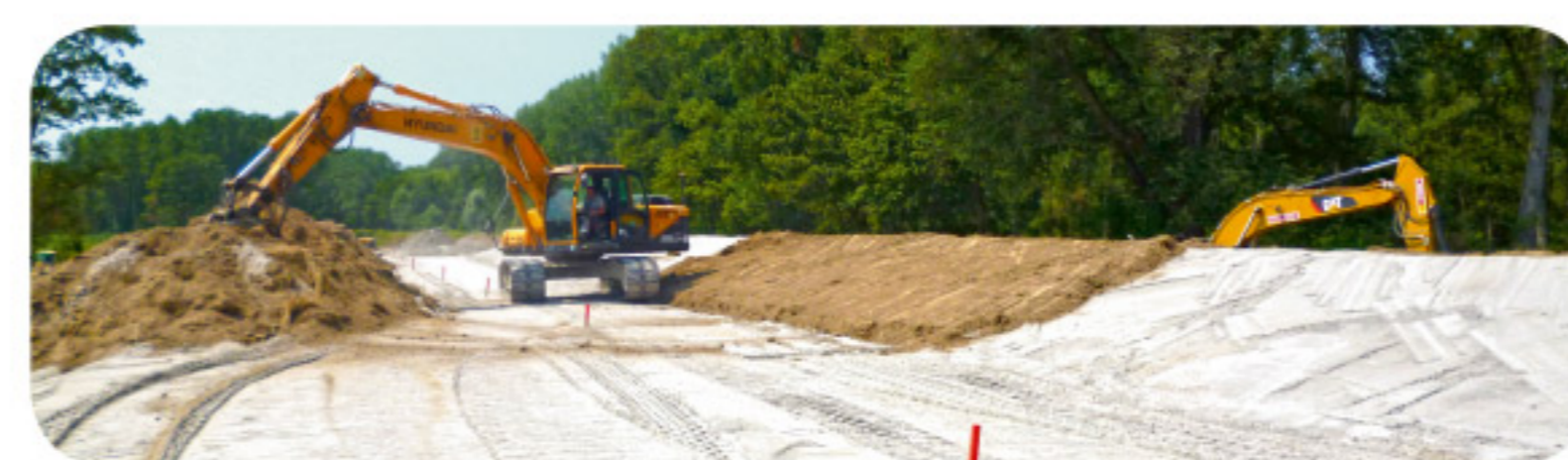
Abbildung: Auftrag von Bodematerial auf den fertigen Dammkörper. Foto: RP Karlsruhe.
