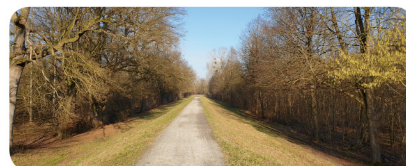
Abbildung: Der Rheinhochwasserdamm vor der Ertüchtigung. Foto: RP Karlsruhe.
