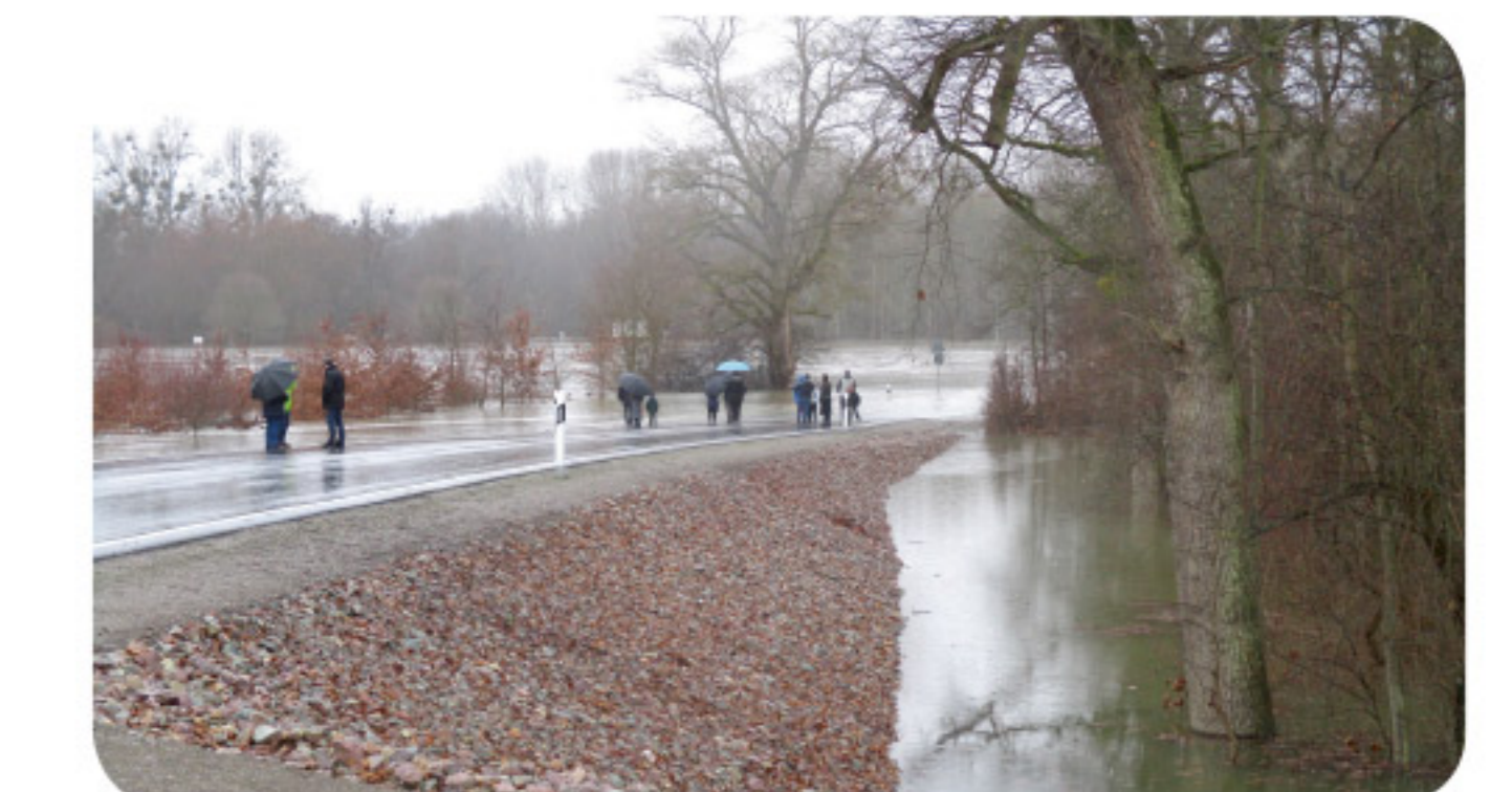
Abbildung: Die Rhein-Seite des neuen Damm-Überganges bei Leopoldshafen während eines Hochwassers im Januar 2021. Foto: RP Karlsruhe.
