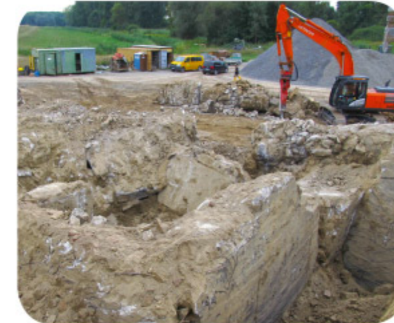
Abbildung: Abriss eines Bunkers. Foto: RP Karlsruhe.
