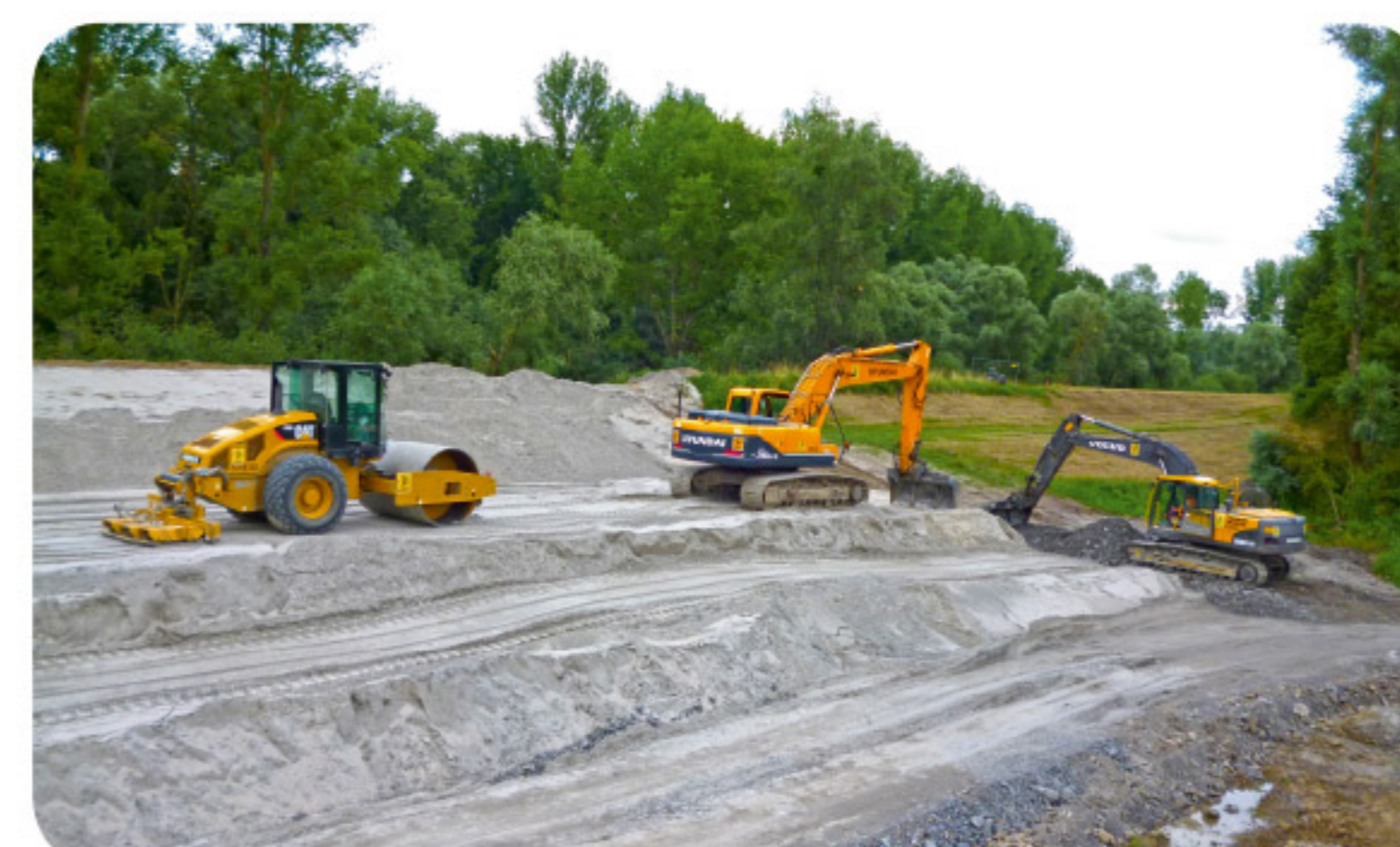
Abbildung: Gestaltung und Verdichtung des neuen Dammkörpers mit Kies-Sand-Gemisch. Foto: RP Karlsruhe.
