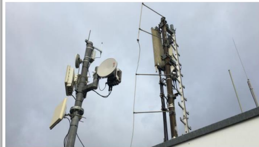
Auf dem Gebäude der Stadtwerke Bochum befindet sich eines von bislang vier LoRaWAN-Gateways. (Foto: energate)
