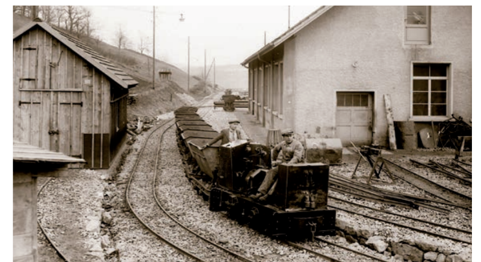
Die Bergwerkbahn hat das Eisenerz zur Zwischenlagerung zum Silo gebracht.
