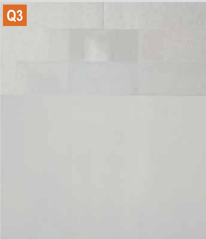
Q3: Knauf TRIAS in AK-Fuge mit Knauf Fugendeckstreifen Kurt (2x gespachtelt) und Knauf Readygips (breiter ausgespachtelt und vollflächig scharf abgezogen, < 1 mm Schichtdicke)
