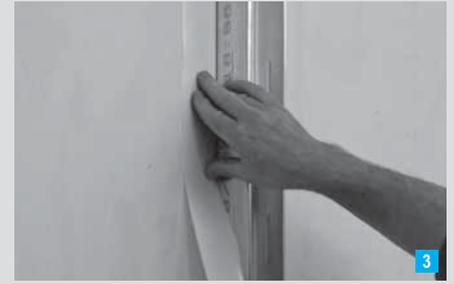
3 Alternativ Knauf Trenn-Fix auf anzuschließendes Bauteil kleben.
