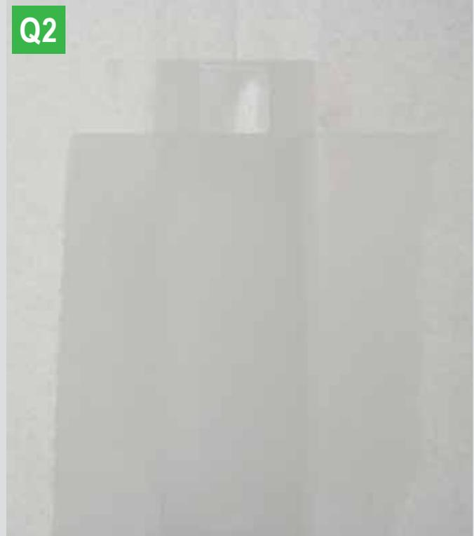
Q2: Knauf TRIAS in AK-Fuge mit Knauf Fugendeckstreifen Kurt (2x gespachtelt).
