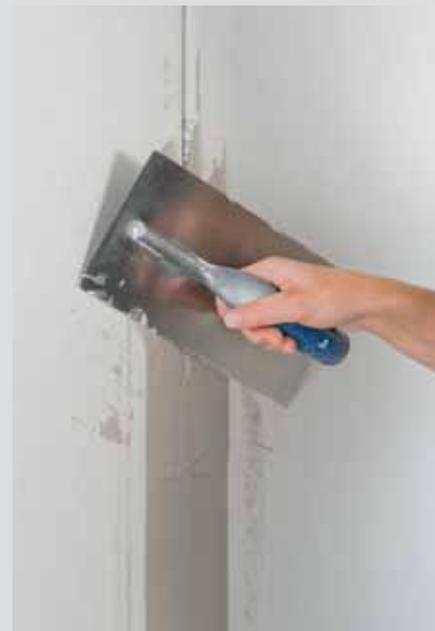
der Schnittkanten mit einem nassen Pinsel reicht nicht aus. Der Gipskern würde auch diese geringe Menge Wasser einfach wegsaugen. Lediglich Knauf Tiefengrund verschließt die Poren an der Schnittkante und reduziert somit das Saugverhalten.
