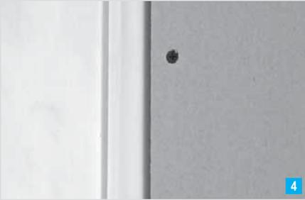
4 Knauf Platten mit 5 mm Abstand montieren
