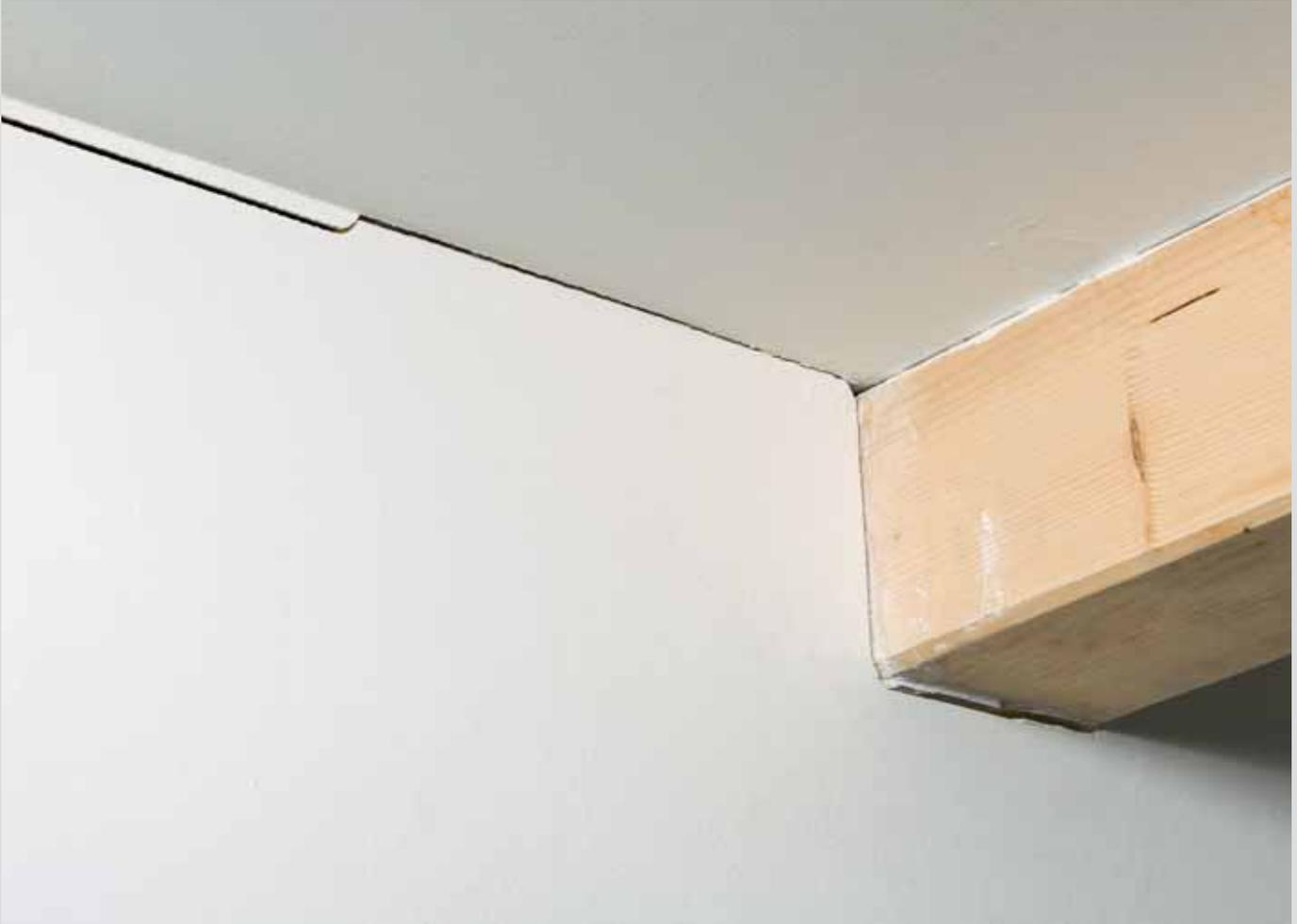
Überspringender Riss aufgrund fehlender Bauteiltrennung
