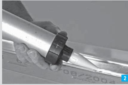
2 Auftragen von Knauf Trennwandkitt zur Abdichtung des Anschlusses bei Bedarf
