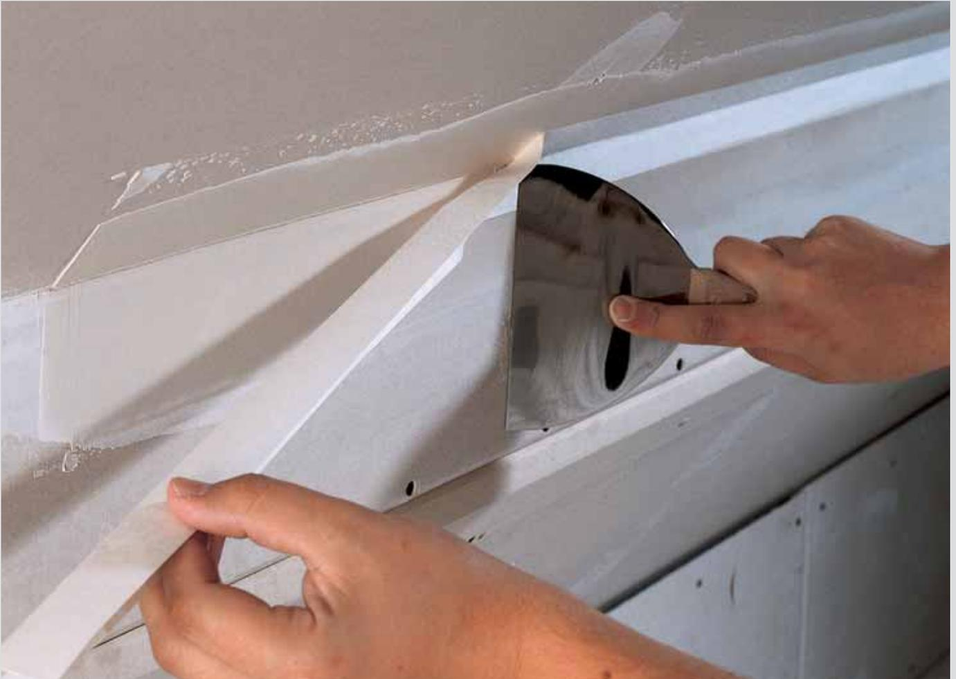
Rissvermeidung mit Knauf Fugendeckstreifen Kurt in der Dachschräge
