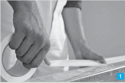
1 Aufdrücken des selbstklebenden Knauf Trenn-Fix auf das CW-/UW-Profil
