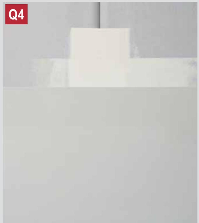
Q4: Knauf Uniflott in HRAK-Fuge (2x gespachtelt) mit Knauf Readygips (vollflächig dick aufgespachtelt, > 1 mm Schichtdicke)
