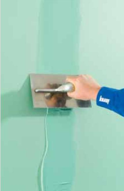
Knauf Uniflott imprägniert für imprägnierte (grüne) Gipsplatten
