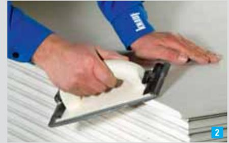
Brechen mit dem Handschleifer bei Knauf Cleaneo-Platten
