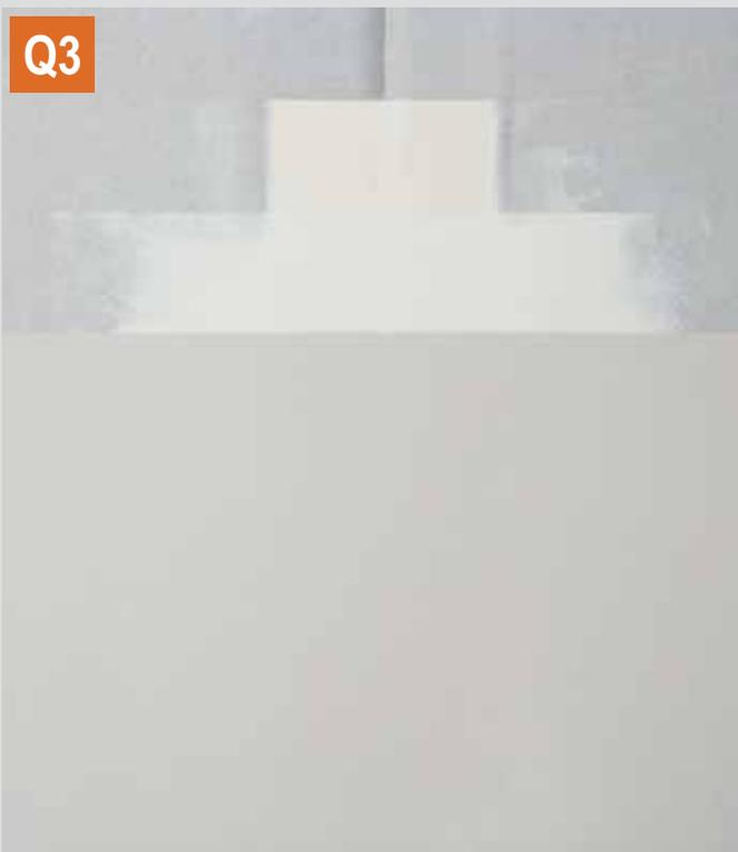
Q3: Knauf Uniflott in HRAK-Fuge (2x gespachtelt) mit Knauf Readygips (breiter ausgespachtelt und vollflächig scharf abgezogen, < 1 mm Schichtdicke)
