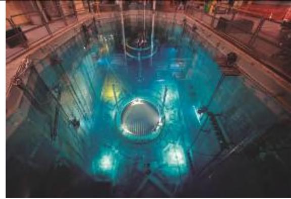
Im Reaktorgebäude während der Revision. Im Normalbetrieb ist das Reaktordruckgefäß (Mitte) geschlossen.
