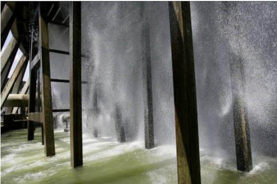
*So sieht es auf dem Boden des Kühlturmes aus. Das versprühte Kühlwasser wird im Kühlbecken gesammelt und zum Kondensator zurückgepumpt.*
