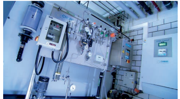
Bild 36: HPW-Wasseraufbereitungsanlage
