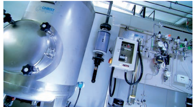
Bild 35: HPW-Wasseraufbereitungsanlage
