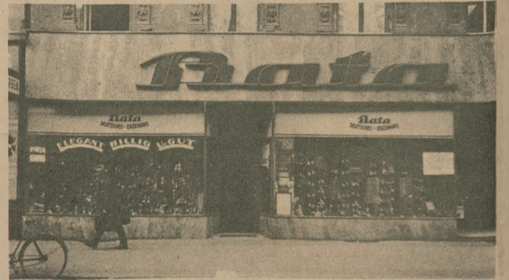
Bata Gleiwitz, Wilhelmstraße 25
