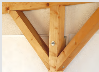
Befestigung von Holzkonstruktionen
