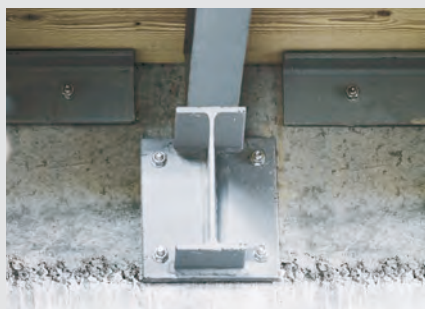
Befestigung von Stahlträgern, Konsolen und Geländern
