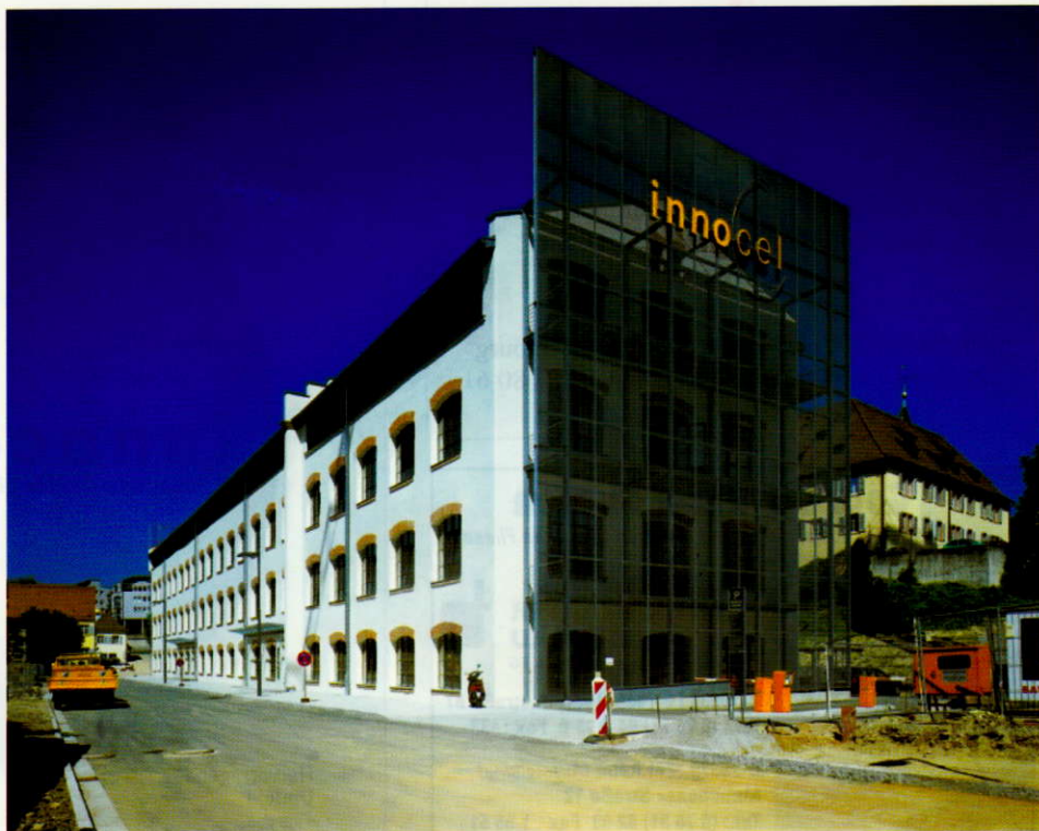
Fabrikhochbau in Lörrach, Marie-Curie-Straße 8
