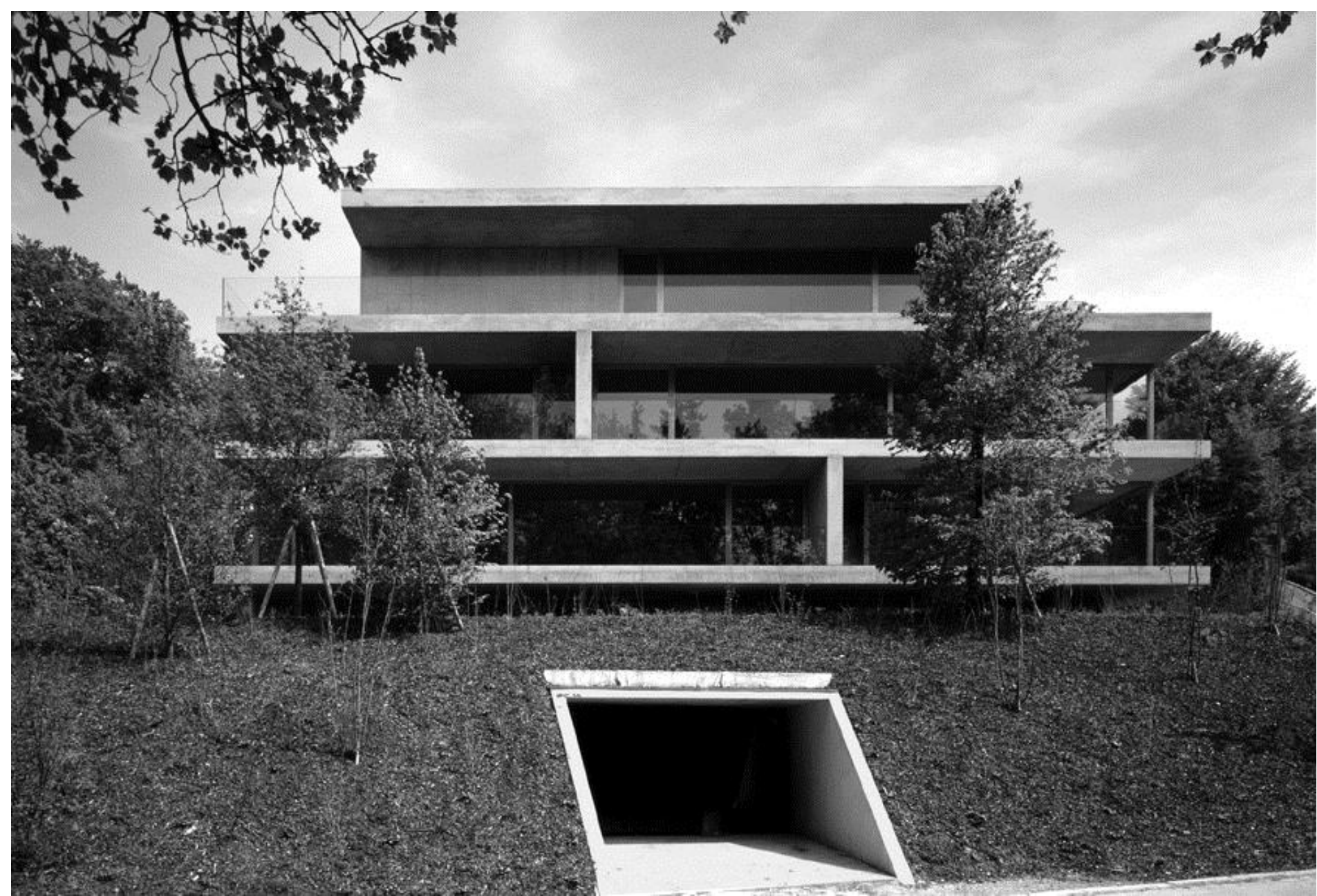
Mehrfamilienhaus Forsterstrasse, Zürich, 2003, Arch.: Christian Kerez, Ing.: Joseph Schwartz
