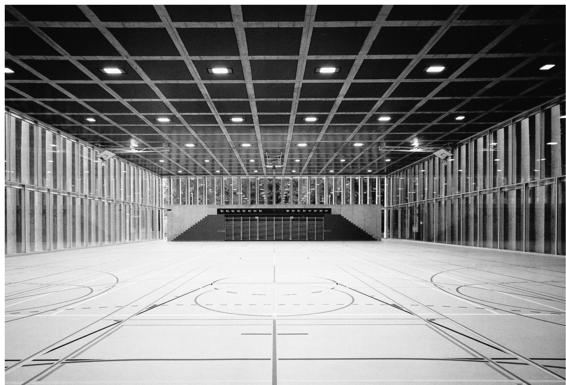
Mehrzweckhalle Losone, 1994 – 97, Arch.: Livio Vacchini, Ing.: R.Rossi
