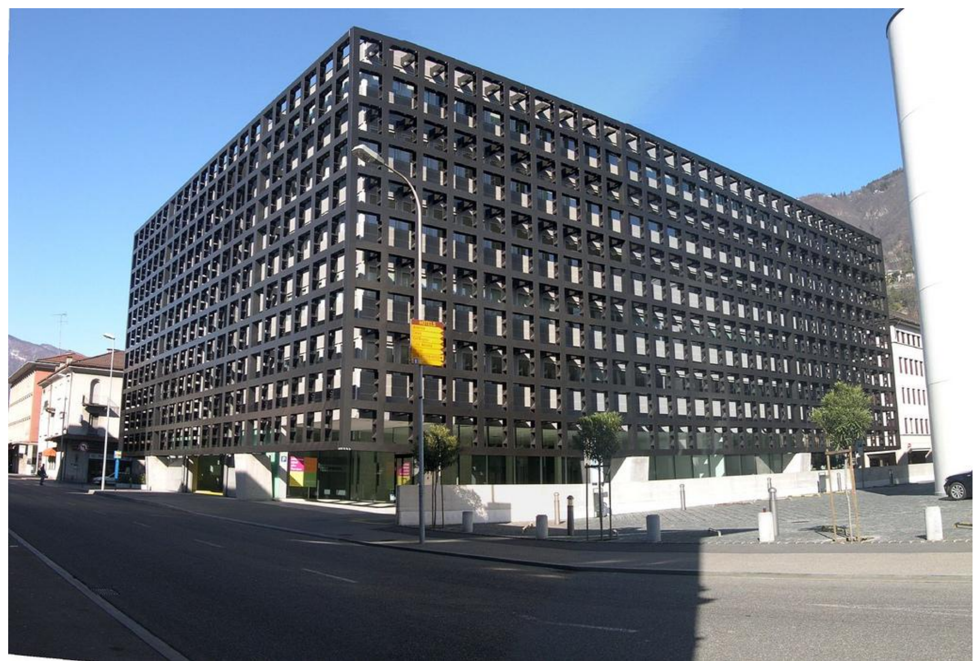
Bürohaus La Ferriera, Locarno, 2003, Arch.: Livio Vacchini, Ing.: Andreoutti + Partners
