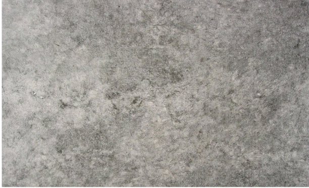
Wolkenbildung infolge Mikroentmischung durch lokales Überverdichten.
