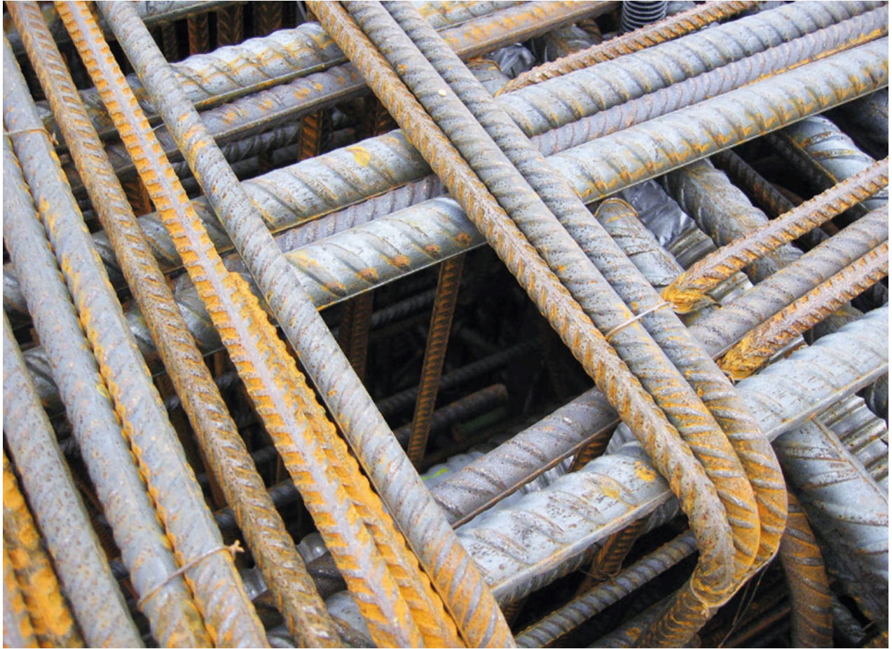
Abb. 8.2.5: Rüttel- und Einfüllöffnung bei eng verlegter Bewehrung.
