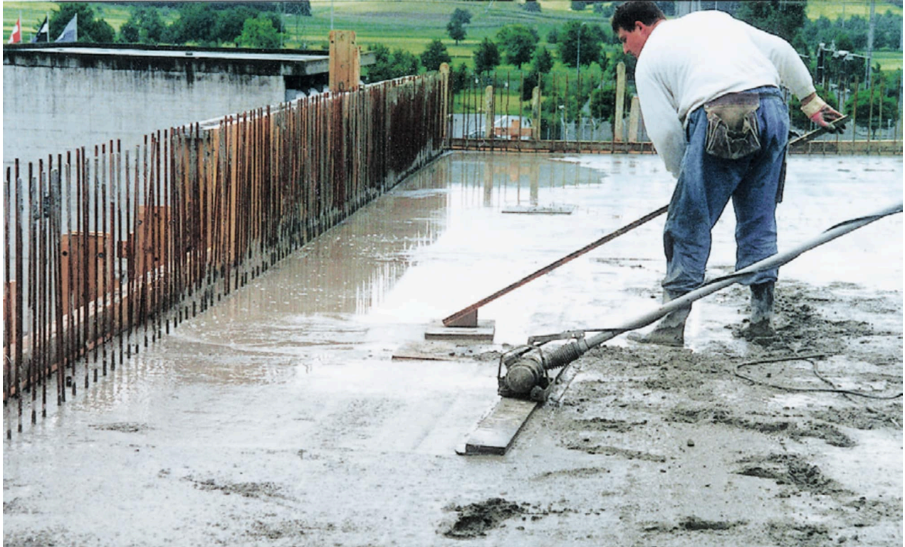
Abb. 8.2.3: Wasser (Blut- und Regenwasser) auf horizontaler Betonoberfläche.
