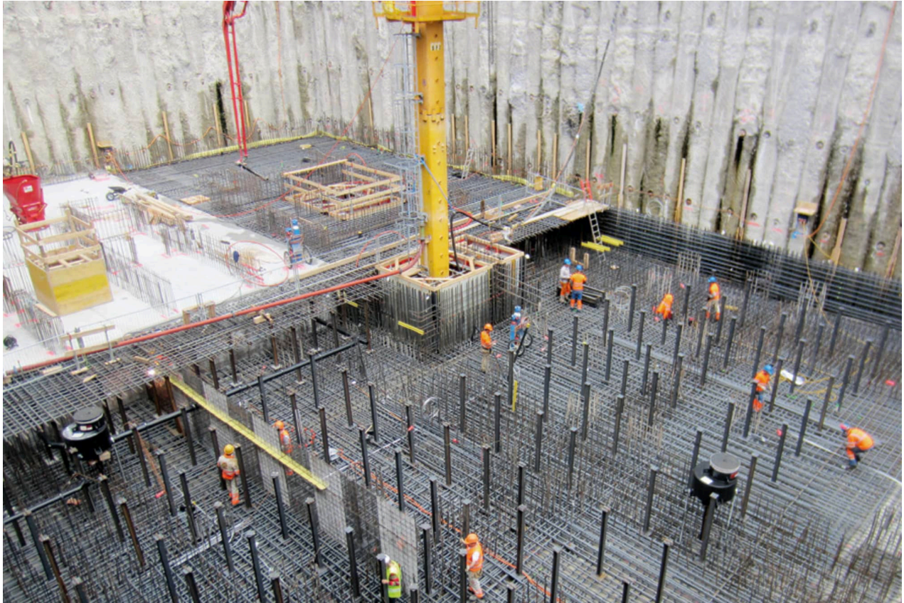
Abb. 3.9.10: Massige Bodenplatte.
