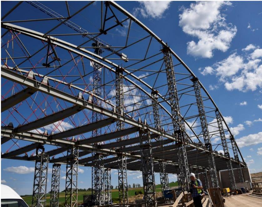
Abbildung 13: Herstellen der Netzwerkbogenbrücke MS-15 auf einem Montagegerüst [20]
