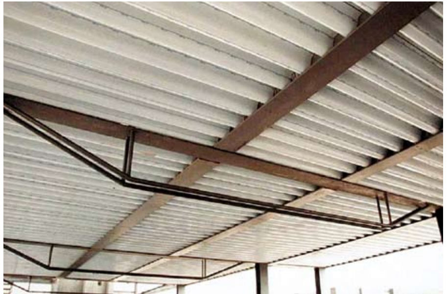
Abb. 3.7 Weitgespannte Variante der Slim-Floor-Bauweise, Handelskammer Luxemburg
