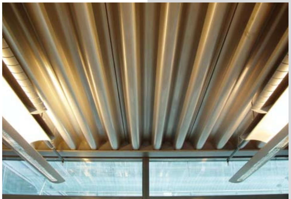
Abb. 2.4 Edelstahl-Verbunddecken in der Handelskammer Luxemburg
