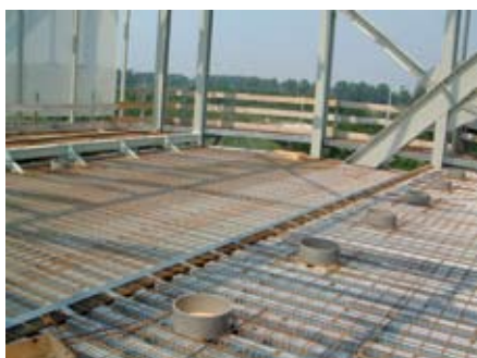
Verbunddecke im Bereich des Auditoriums
