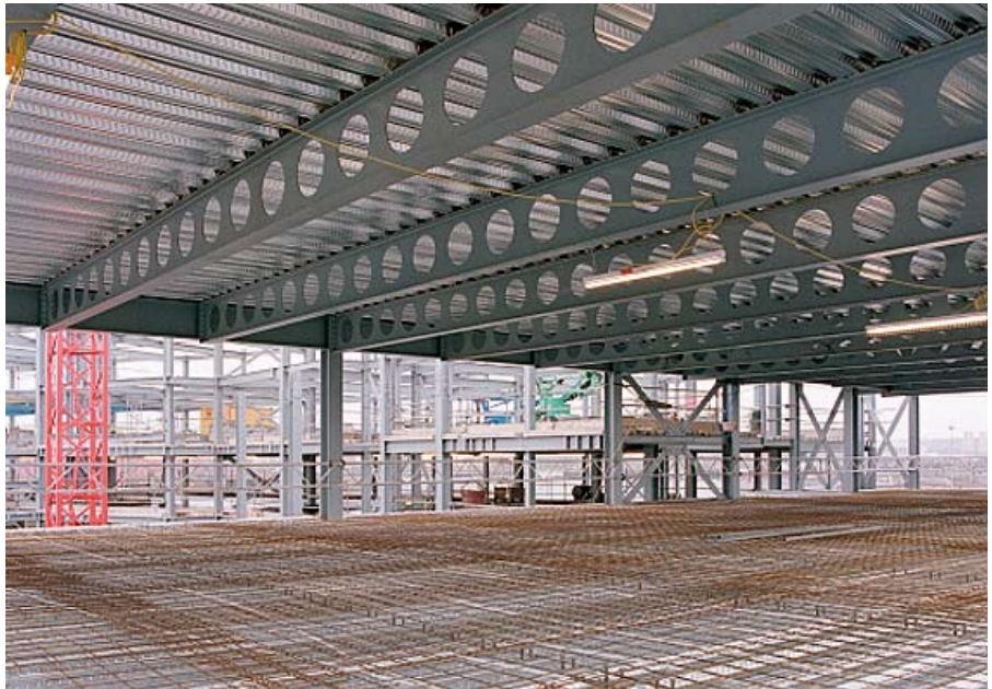
Abb. 3.8 Cellformträger mit runden Stegöffnungen in regelmäßigen Abständen
