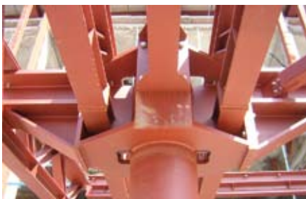
Geschraubte Verbindung im Eckbereich zwischen zwei Würfeln
