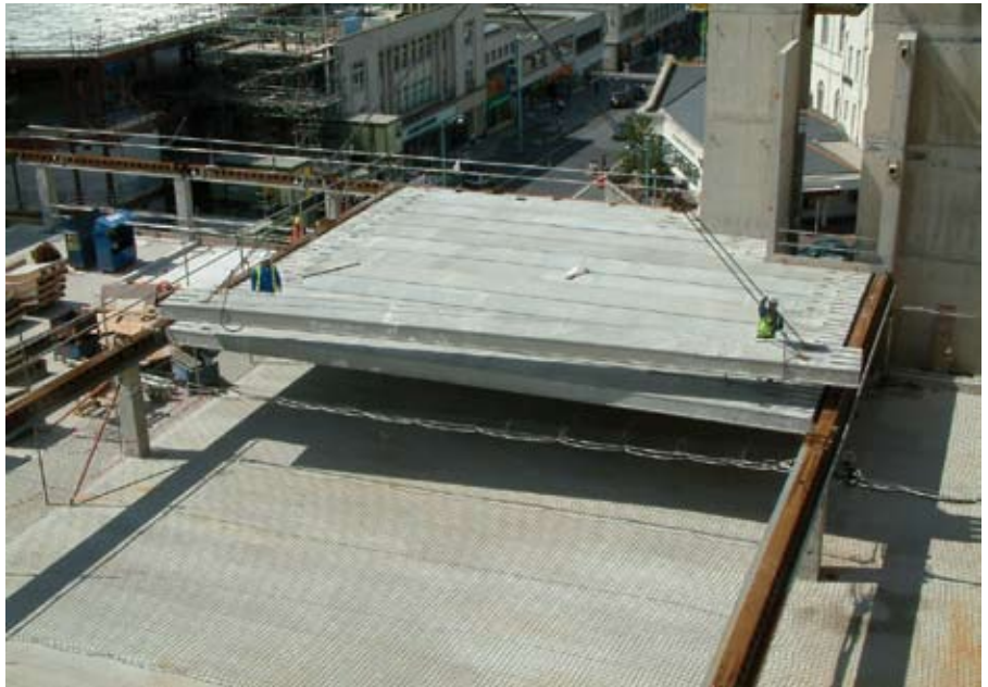
Abb. 3.17 Betonfertigteile auf Stahlträgern ohne Verbundwirkung
