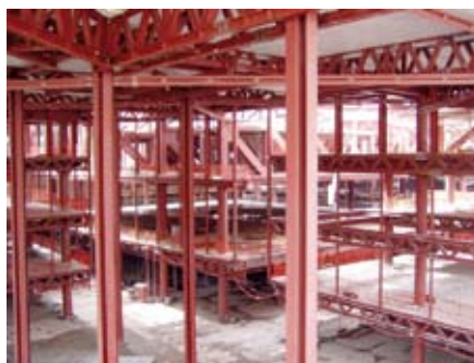
Stahlkonstruktion der Eingangshalle
