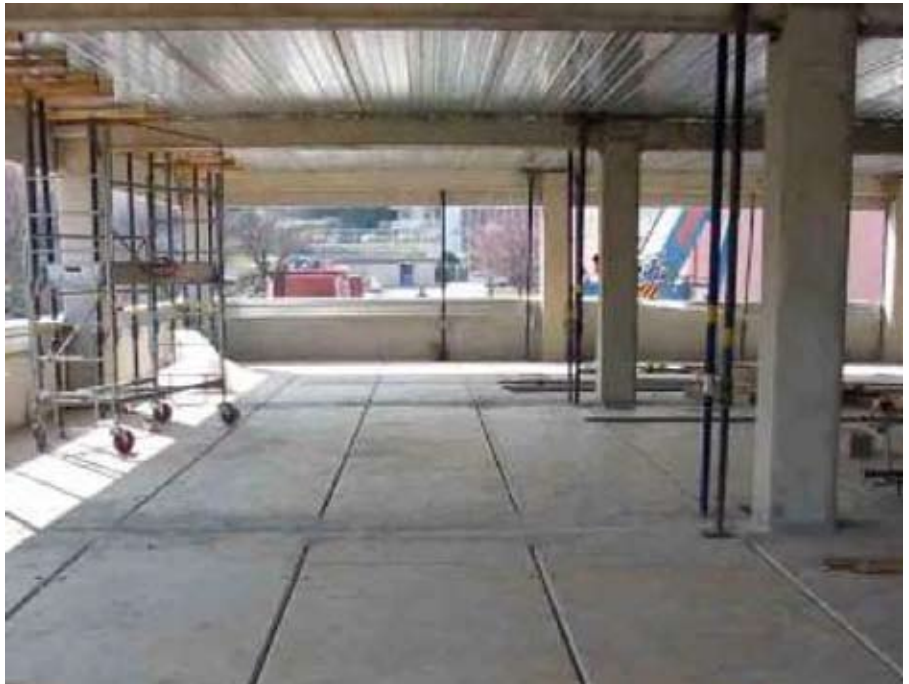
Abb. 4.3 Ansicht einer Cofradal-Decke vor dem Betonieren
