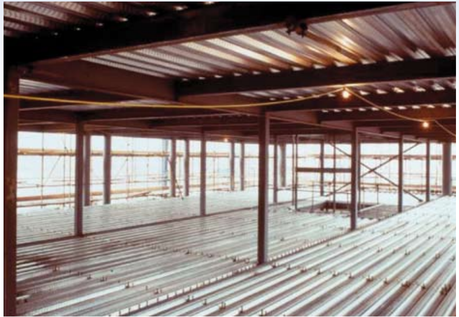
Abb. 2.1 Verbunddecken schaffen eine sichere Arbeitsplattform während der Montage
