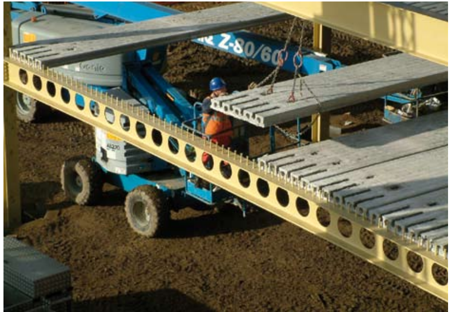
Abb. 3.13 Verbundkonstruktion aus vorgespannten Hohlplatten und Cellformträgern
