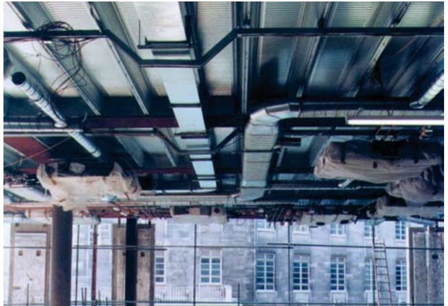
Abb. 4.8 Anordnung von Versorgungsleitungen unter einer Slimdek-Decke
