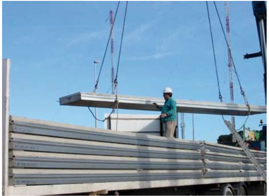
Abb. 4.2 Anlieferung auf der Baustelle
