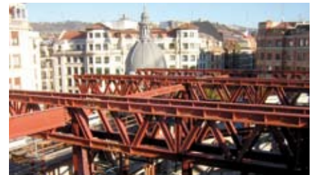
Umlaufende Kragträger im Bereich des Atriums
