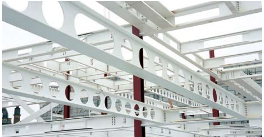
Abb. 3.11 Cellformträger aus Walzprofilen mit Brandschutzbeschichtung
