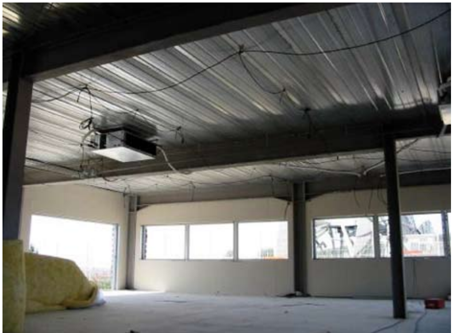
Abb. 4.4 Untersicht einer fertiggestellten Cofradal-Decke. Eine Abhangdecke dient der Leitungsführung.
