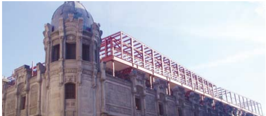
Alhóndiga im Bauzustand
