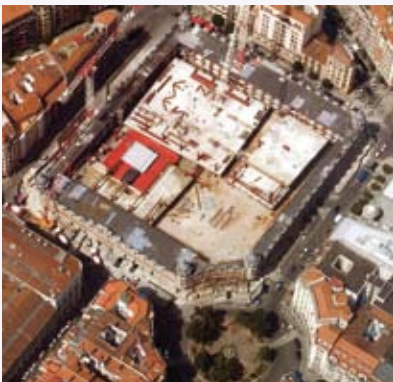
Aufsicht der Baustelle (Mai 2006)
