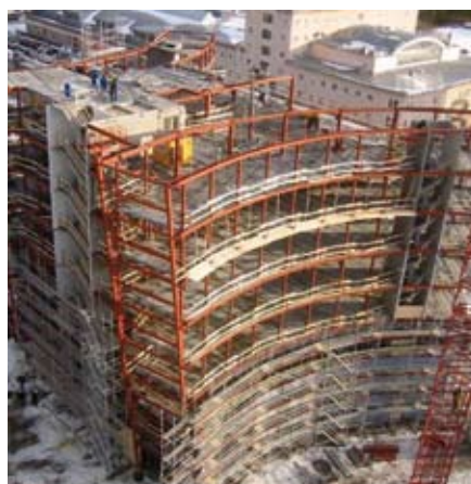
Mjärdevi Center während der Bauphase. Primärtragwerk und leichte Unterkonstruktion der Fassade (Bildrechte:PPTH)
