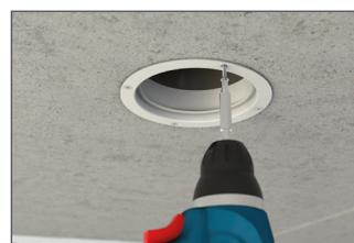
Adapterring an Lüftungshülse schrauben
