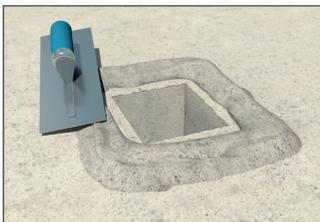
Betonrand betonieren, damit kein Wasser ins darunterliegende Geschoss laufen kann
