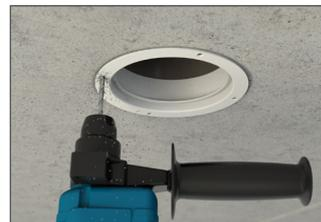
Löcher für Adapterring manuell bohren
