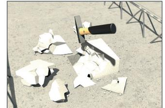
Styroporausparung auf der Baustelle zeitaufwendig entfernen
