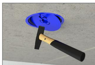
Deckel der Lüftungshülse einschlagen
