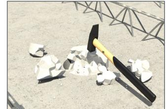
Styroporausparung auf der Baustelle zeitaufwendig entfernen
