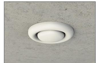
Lüftungsauslass montieren - Fertig
