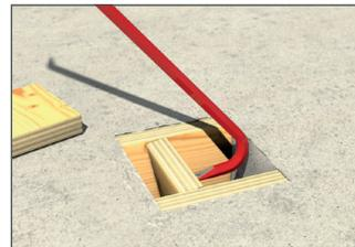
Nach dem Betonieren Holzschalung entfernen
