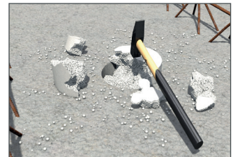
Styroporausparung auf der Baustelle zeitaufwendig entfernen
