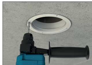
Löcher für Adapterring manuell bohren
