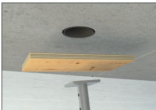
Gegenschalung im Untergeschoss demontieren
