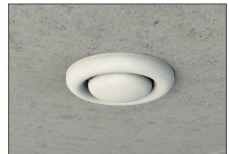
Lüftungsauslass montieren - Fertig
