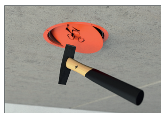
Deckel der Lüftungshülse einschlagen
