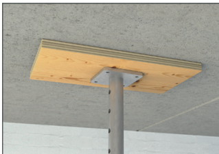
Gegenschalung im Untergeschoss herstellen
