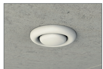
Lüftungsauslass montieren - Fertig
