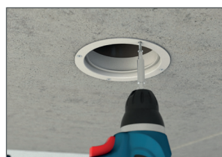
Adapterring an Lüftungshülse schrauben
