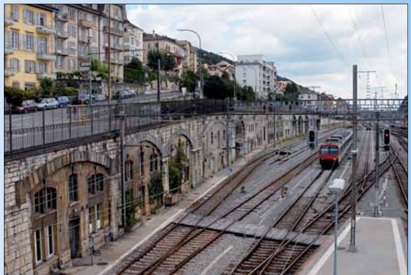
Wie die erhöht liegende Straße und Häuserzeile im nebenstehenden Plan des Vorortbahnhofs Typ D 1 S ausgeführt werden könnte, zeigt die Vorbildsituation des Schweizer Bahnhofs Neuchâtel. Das Bild entstand vom Fußgängerübergang aus. Ein derartiger Übergang ist auch im Modell eingezeichnet.
