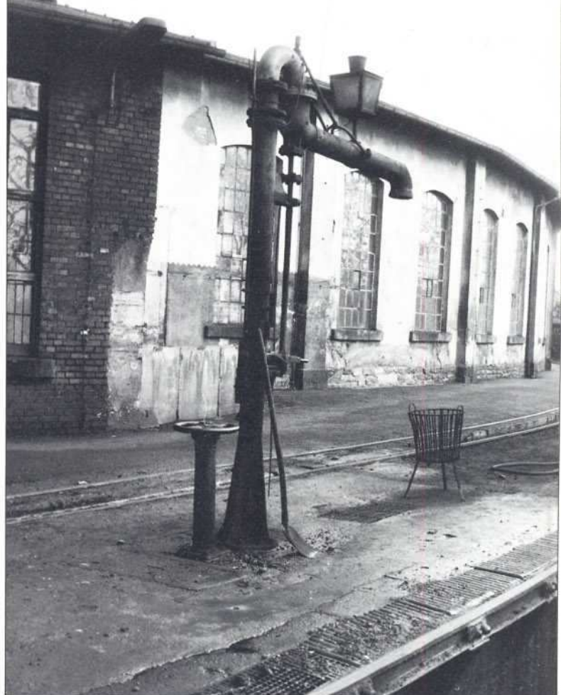
Bild 9: Hinter dem Ringlokschuppen befindet sich die Zufahrt zum Schmalspur-Lokschuppen mit den beiden Untersuchungsgruben und einem Wasserkran.
