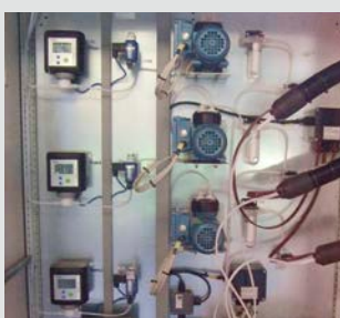
Sauerstoffüberwachungssystem Integriert in die SMP Steuerungssoftware
