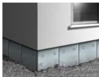
Mauerwerk (Sockel gedämmt)
