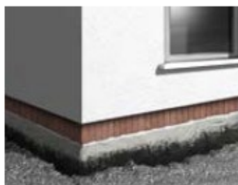
Mauerwerk (Sockel ungedämmt)
