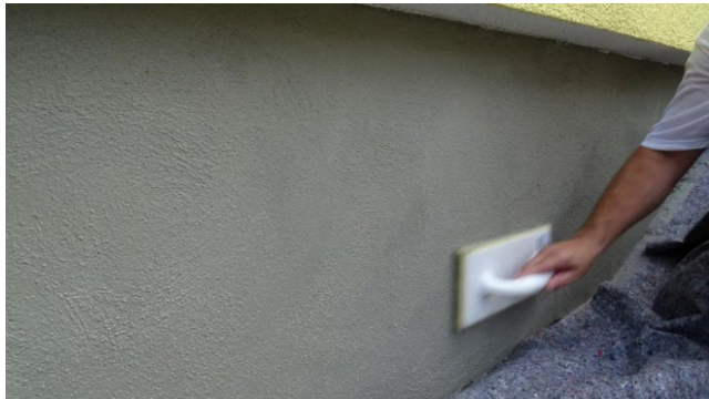
als Sockelfilzputz / Oberputz
