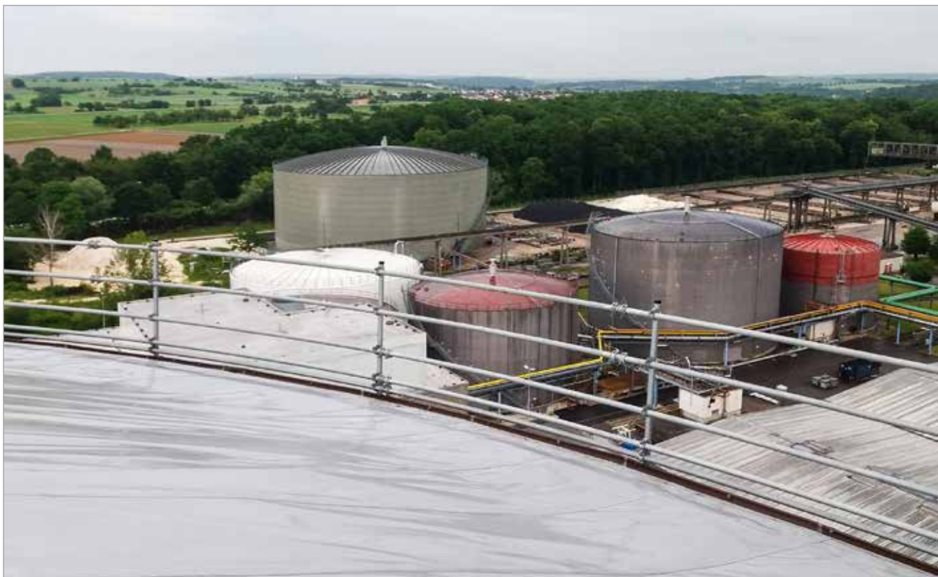
Die festinstallierten Gerüste von Sifatec passen sich der runden Dachkonstruktion in Offenau individuell an.
