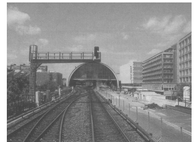
Bf Alexanderplatz. Anlässlich der Pressekonferenz am 19.06.95 ermöglichte die DB AG auch eine Fahrt im Führerstand über die gesamte Stadtbahn-Baustelle. (Foto: Marc Heller)
