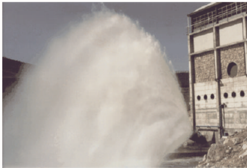
Bild 5.19: Freie Strahlentlastung durch bypass
