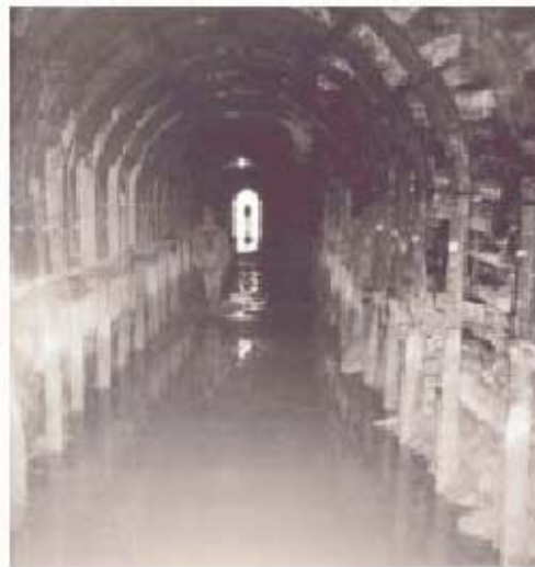
Bild 4.5: Sicht auf die Tunnelarbeiten
