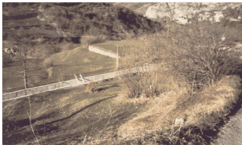
Bild 7.6: Konstruktions Phase – Betonkanal
