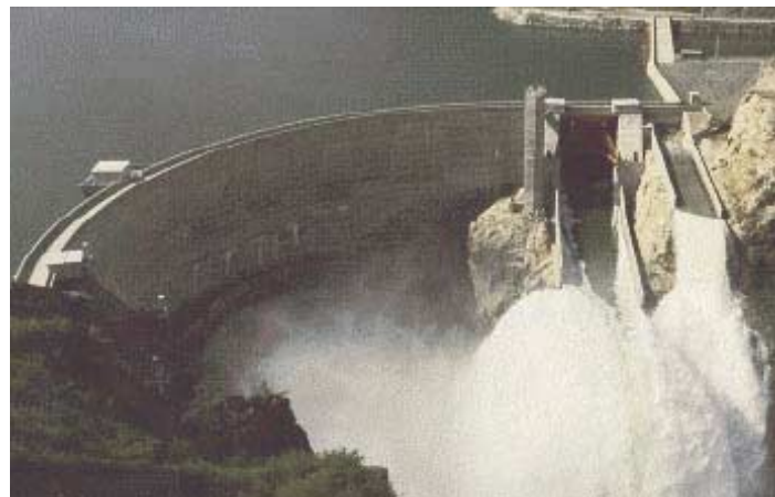
Bild 5.2: Beispiel einer Bogenstaumauer
