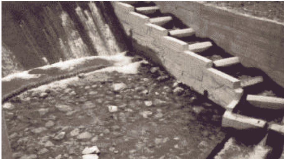
Bild 7.14: Fischpass mit vertikalen Schlitten
