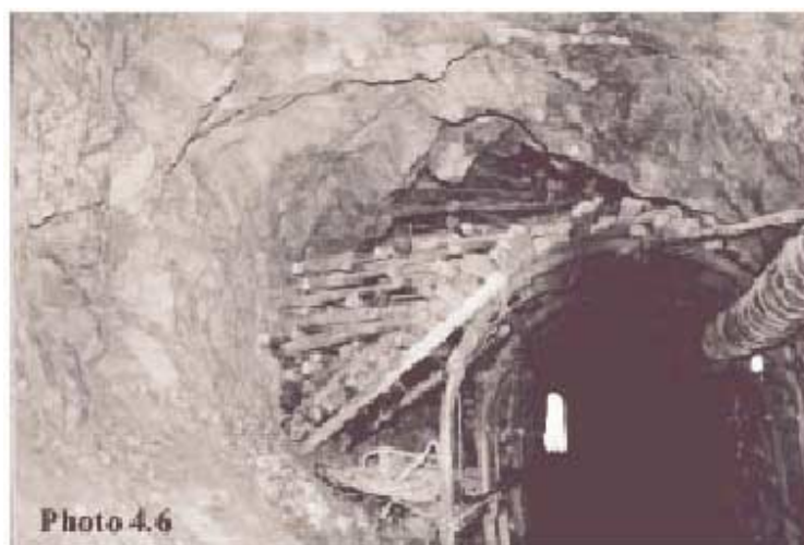
Bild 4.6: Sicht auf die Tunnelverkleidung
