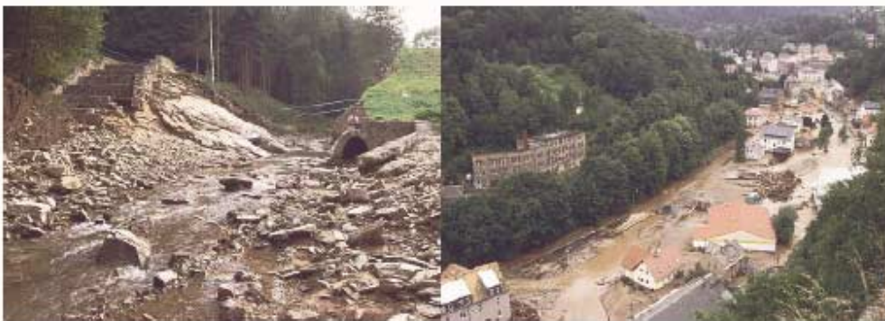
Bild 5.3: Bruch eines kleinen Damms, der Bruch und die Überflutung stromabwärts.
