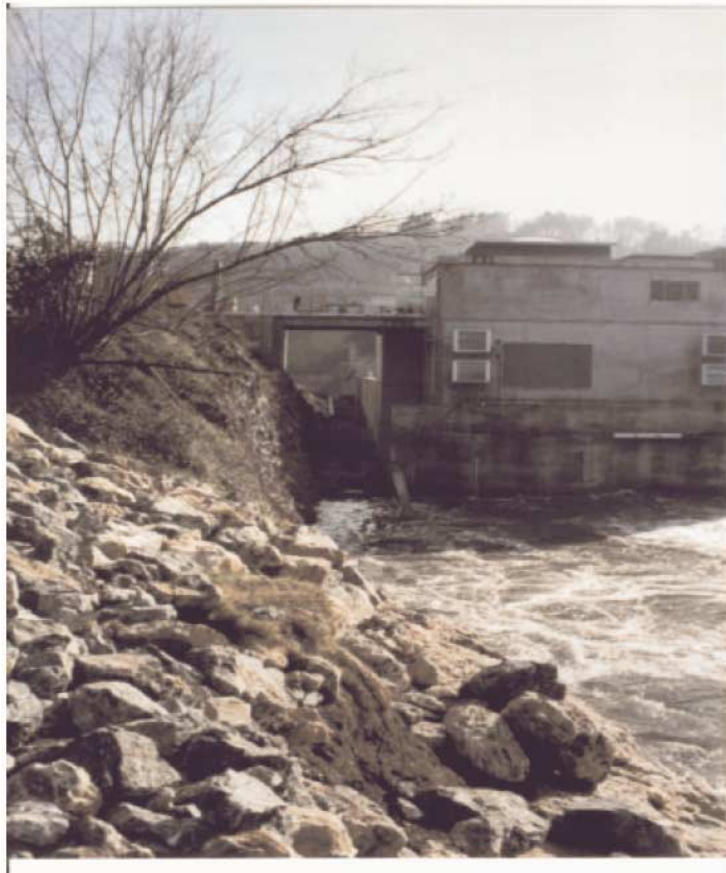
Bild 7.16: Kraftwerk, Fischpass links
