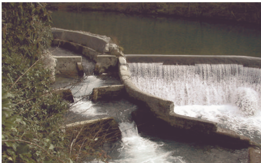
Bild 7.13: rustikaler Beckenpass
