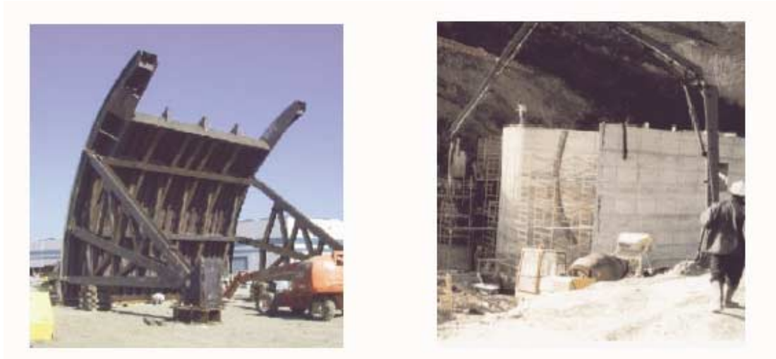
Bild 5.15: Segmentwehr (links) und Einbausituation des Segmentes zwischen Betonpfeilern
