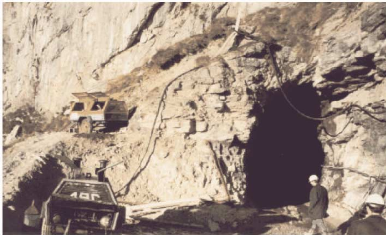
Bild 7.8: Stolleneingang während der Konstruktionsphase
