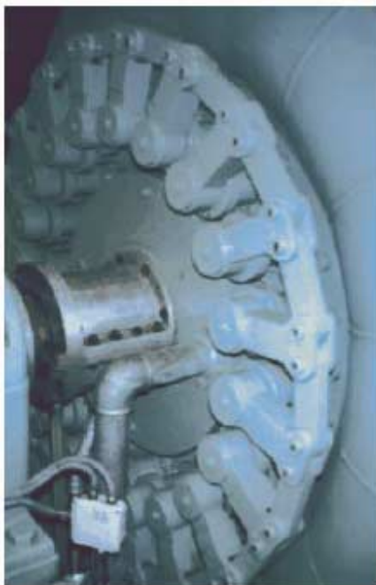
Bild 6.4: Leitradring bei einer horizontalachsigen Francisturbine
