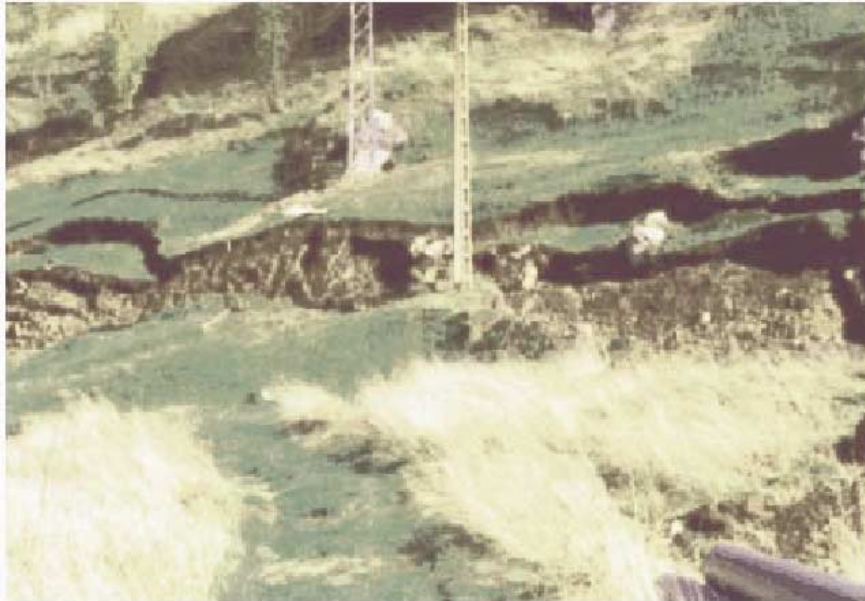
Bild 4.1: Überblick über die rechtsufrige Böschung
