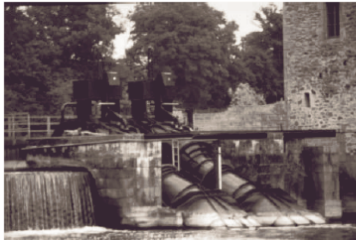
Bild 6.7: Kaplan Heberturbine
