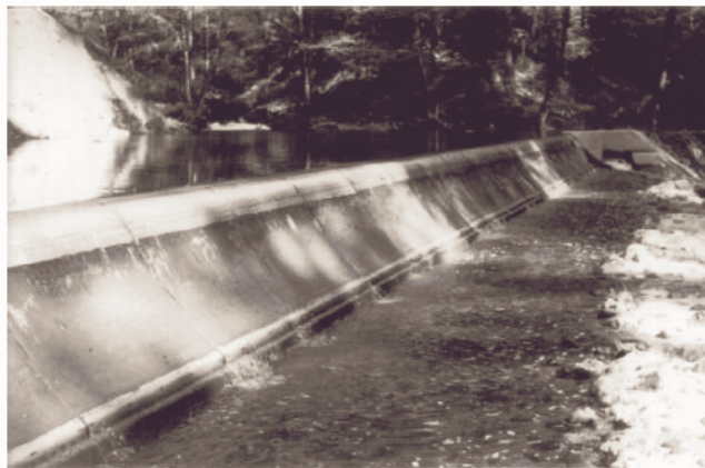
Bild 7.17: Coanda Rechen in Betrieb
