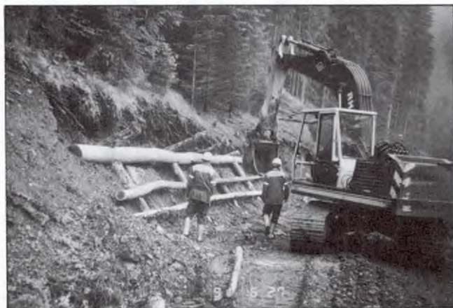
Die Arbeiten beim Wegbau im "Tamalwald" Klausenberg. Foto S. Stocker
