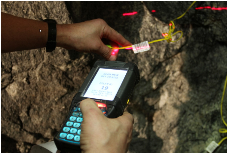
Bild 3: Einscannen des Barcodes an der Ortsbrust mit dem eDev™ Scanner
