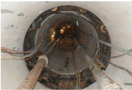
Blick in Vortriebsrohre während laufender Vortriebsarbeiten.
