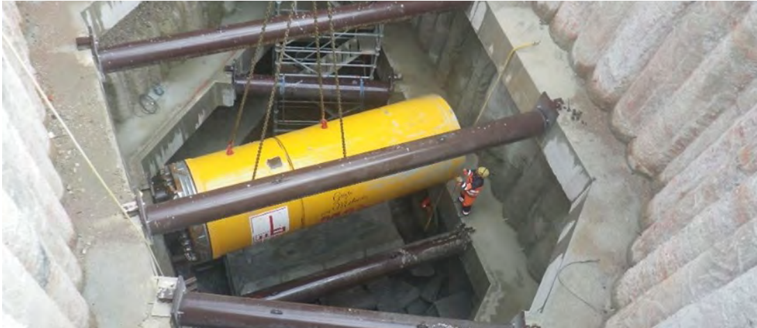
Bergen der Vortriebsmaschine in der Zielbaugrube (Dükerunterhaupt).
