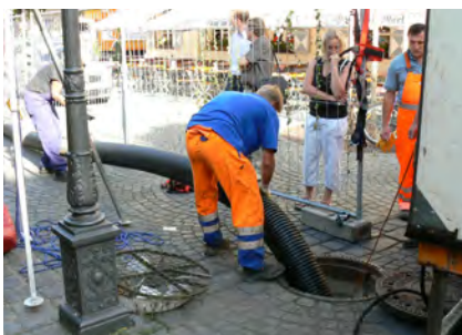
Einziehen eines vorgefertigten Rohrstranges in einen nicht begehbaren Kanal
