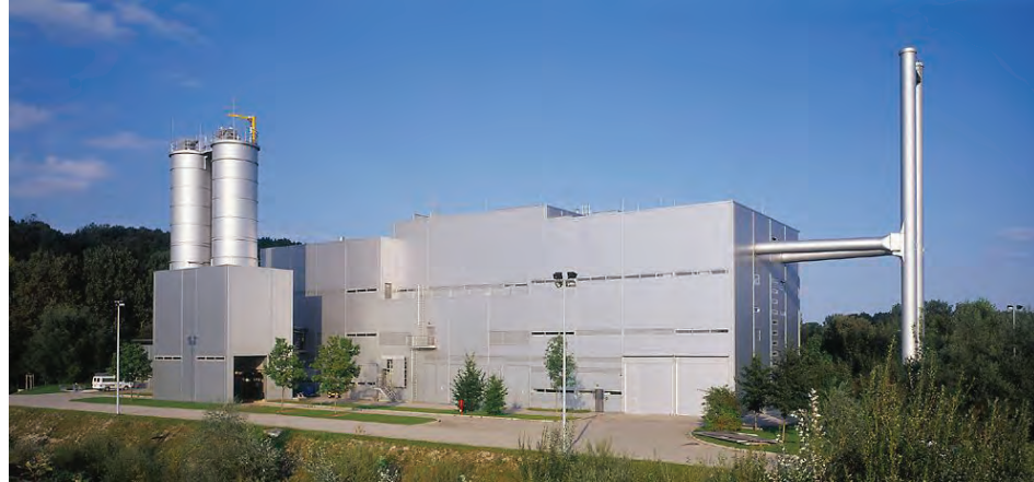
In der Klärschlammverbrennungsanlage werden jährlich rund 792.000 Kubikmeter Klärschlamm aus beiden Klärwerken verbrannt.
