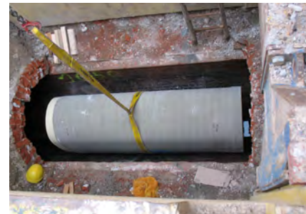
Einheben von vorgefertigten Rohren in einen begehbaren Mauerwerkskanal
