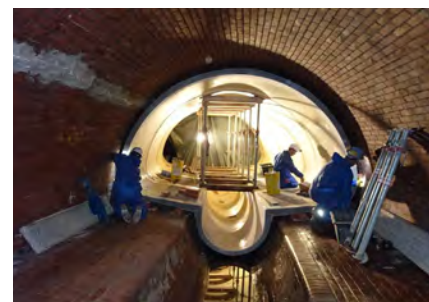
Großprofilsanierung mittels vorgefertigter Rohrprofile
