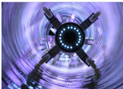
Aushärtung eines Liners (harzgetränkter Glasfaser-schlauch) im Kanal durch eine starke Lichtquelle.
