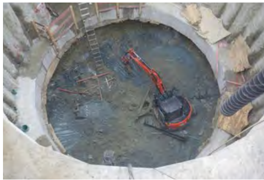
Abbruch der Mergelschicht in der Startgrube (Dükeroberhaupt).
