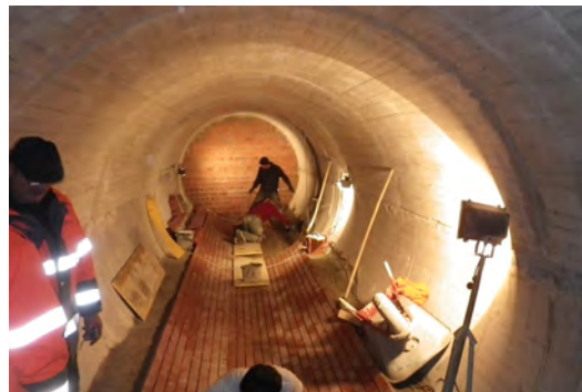
Sohlarbeiten im Kanalneubau des Laimer Kreisel
