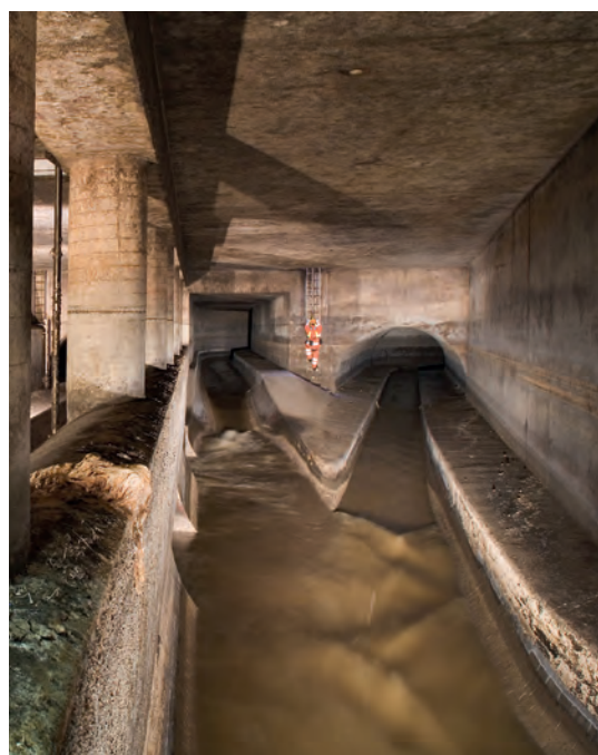
Der Abwasserzufluss zu den beiden Klärwerken wird durch unterschiedliche Schieberstellungen in den Verteilerbauwerken zentral von der Warte des Klärwerks Gut Großlappen aus gesteuert. Um die Funktionsfähigkeit zu sichern, müssen sie regelmäßig kontrolliert werden.
