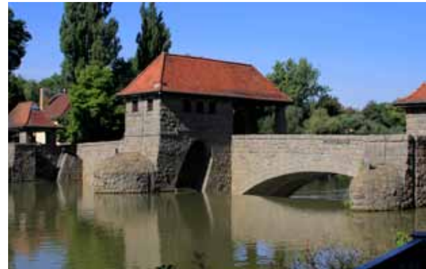
Technische Bauten gehören zur blauen Infrastruktur, im Bild das Palmengartenwehr.
