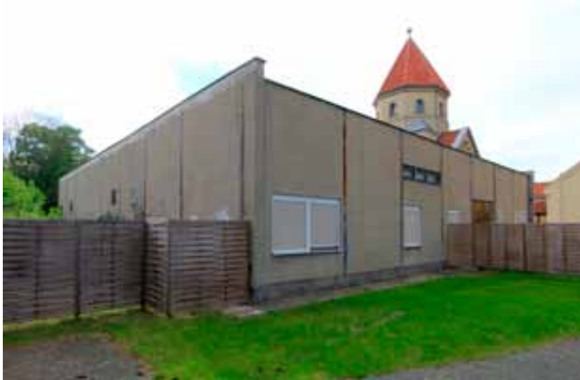
Der Abbruch eines Betriebsgebäudes (Foto links), die Entsiegelung und Bepflanzung (Foto unten) war Gegenstand einer Kompensationsmaßnahme am Krematorium auf dem Südfriedhof.
