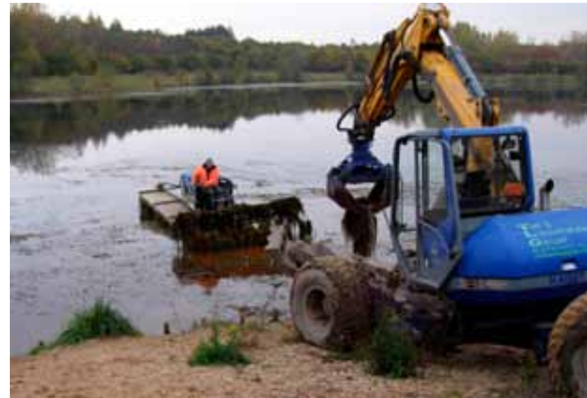
Die Entkrautung und Entschlammung gehört zu Unterhaltungsaufgaben an Gewässern.
