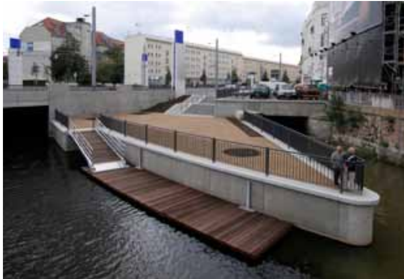
Der Anspruch bei der Offenlegung verrohrter Gewässer ist es, diese erreichbar und erlebbar zu machen.
