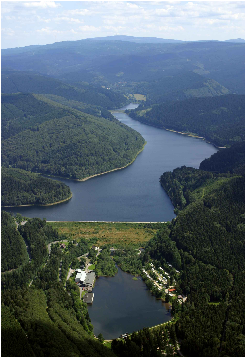
Abbildung 2: Sösetalsperre mit Wasserwerk (links)
