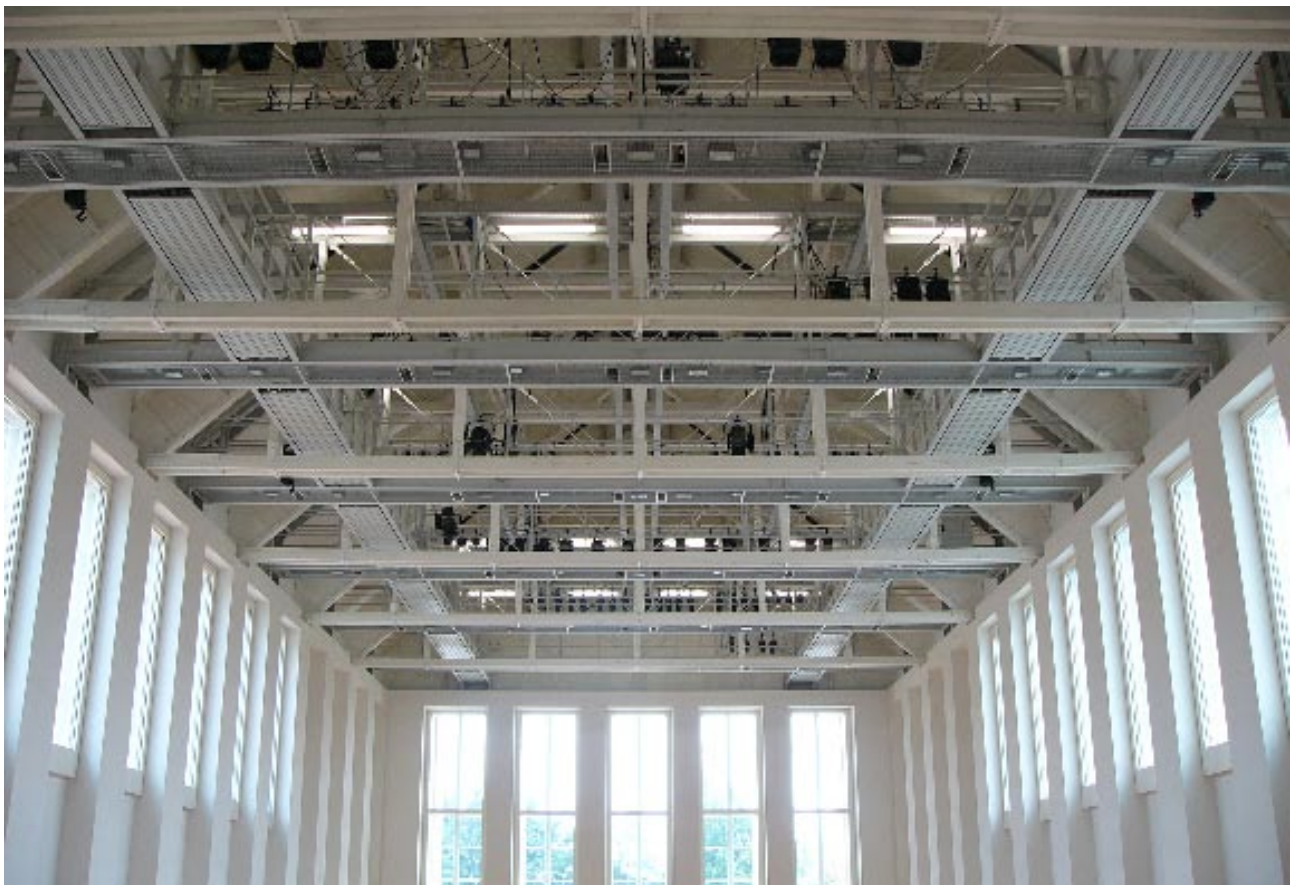
Blick in Dachstuhl
