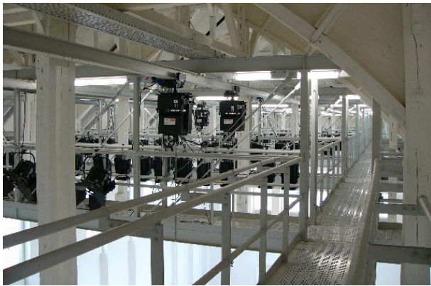
Stegebene im Dachbereich
