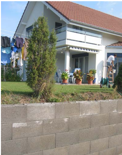
Bild 1: SCHALIT Schalungsstein als Hangsicherung
