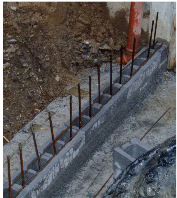
Bild 11: Horizontale und vertikale Bewehrung (Produktneutral)
