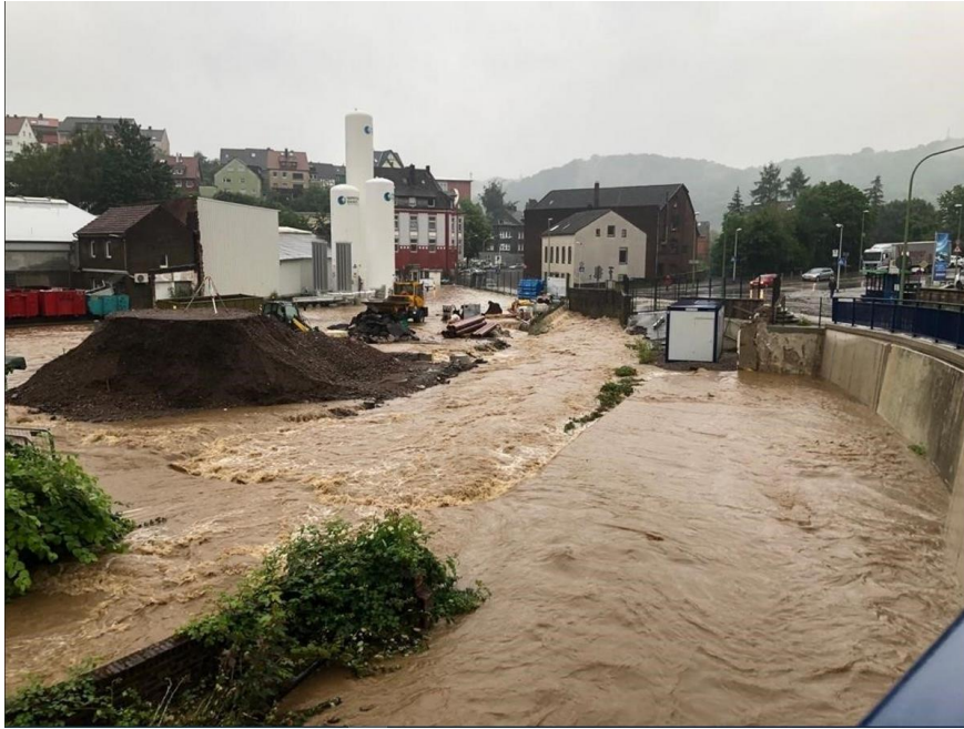
Überschwemmungsschäden in Hagen, NRW. Quelle: Feuerwehr Hagen.
