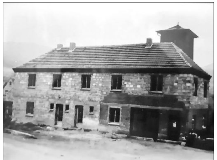
Das neue Gerätehaus blieb noch einige Jahre unverputzt. Die Räume der Feuerwehr, Garage und Umkleide, sowie die alte Saugstelle lassen sich noch gut erkennen.
