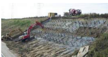
Böschungssicherung
