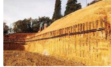
Baugrundsicherung in Fréjus, Frankreich
