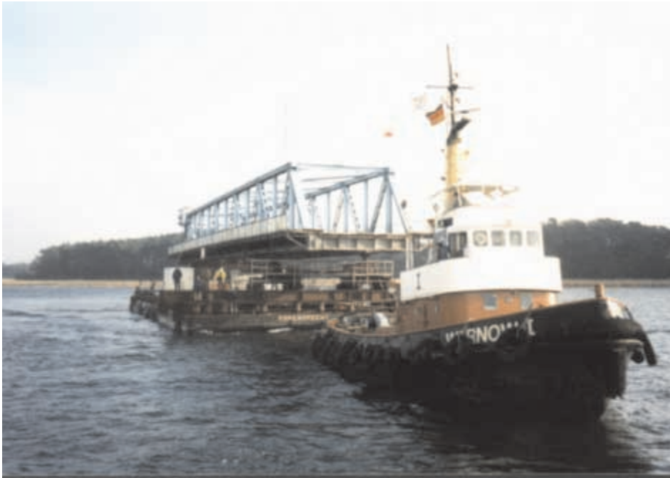
Bild 10.5: Ausschwimmen Fachwerküberbau, Peenebrücke Wolgast
