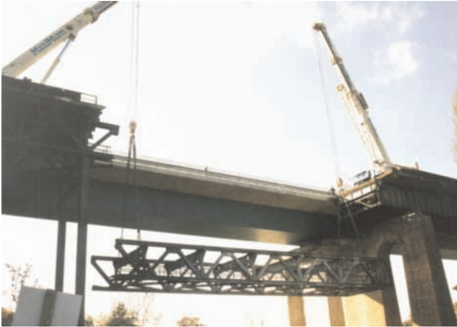
Bild 10.3: Kranrückbau, Kalkgrabenbrücke BAB A 10
