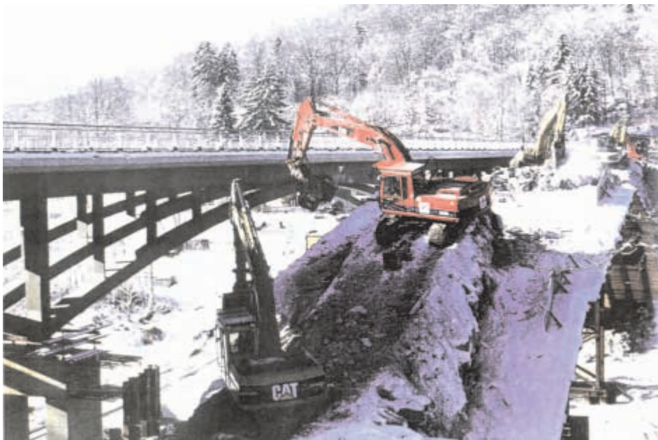
Bild 10.2: Maschineller Abbruch auf Traggerüst, Isarbrücke München
