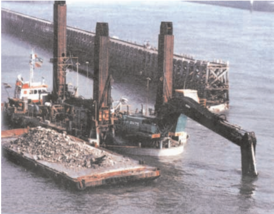
Bild 10.7: Beräumen Sprengmassen unter Wasser
