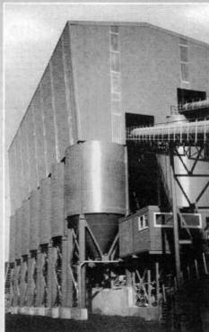
SIT-Reihen-Siloanlagen werden überall dort eingesetzt, wo unterschiedliche Kornfraktionen zu lagern oder aufzubereiten sind.
