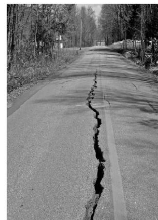
Abbildung 14: Schadensbild (Längsris) hervorgerufen durch Frosthebung (Doré & Zubeck, 2009)
