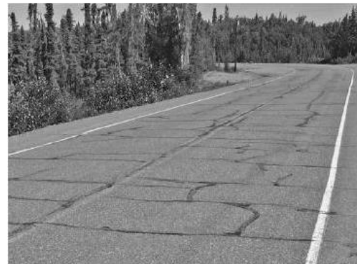
Abbildung 11: Schadensbild bei verhindertem thermischen Schrumpf (Doré & Zubeck, 2009)
