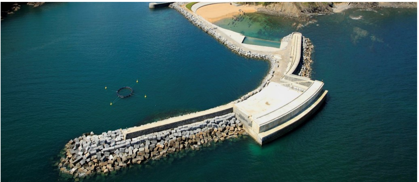
Abbildung 4 OWC-Wellenkraftwerk Mutriku, angepasst nach (Bilbao Exhibition Centre 2015)
