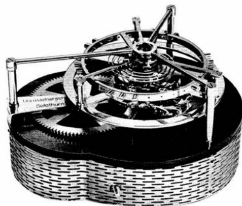
Ein Highlight aus jener Zeit: Das von Praxislehrer Franz Schmidlin hergestellte Tourbillonmodell in zehnfacher Vergrößerung wird an der Weltausstellung in Brüssel 1958 ausgestellt. (75-Jahr-Festschrift, S.41)
