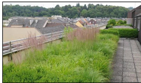
Abb. 16: Dachbegrünung in Linz, Österreich (Quelle: http://www.kriegergut.at/img/projekte/Schwestern-Dach-Q1.jpg )
