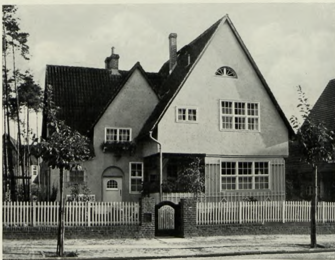
ARCHITEKT HEINRICH STRAUMER-BERLIN. HAUS TRAPP UND THIEDIG IN FROHNAU. ANSICHTEN VON DER STRASSE
