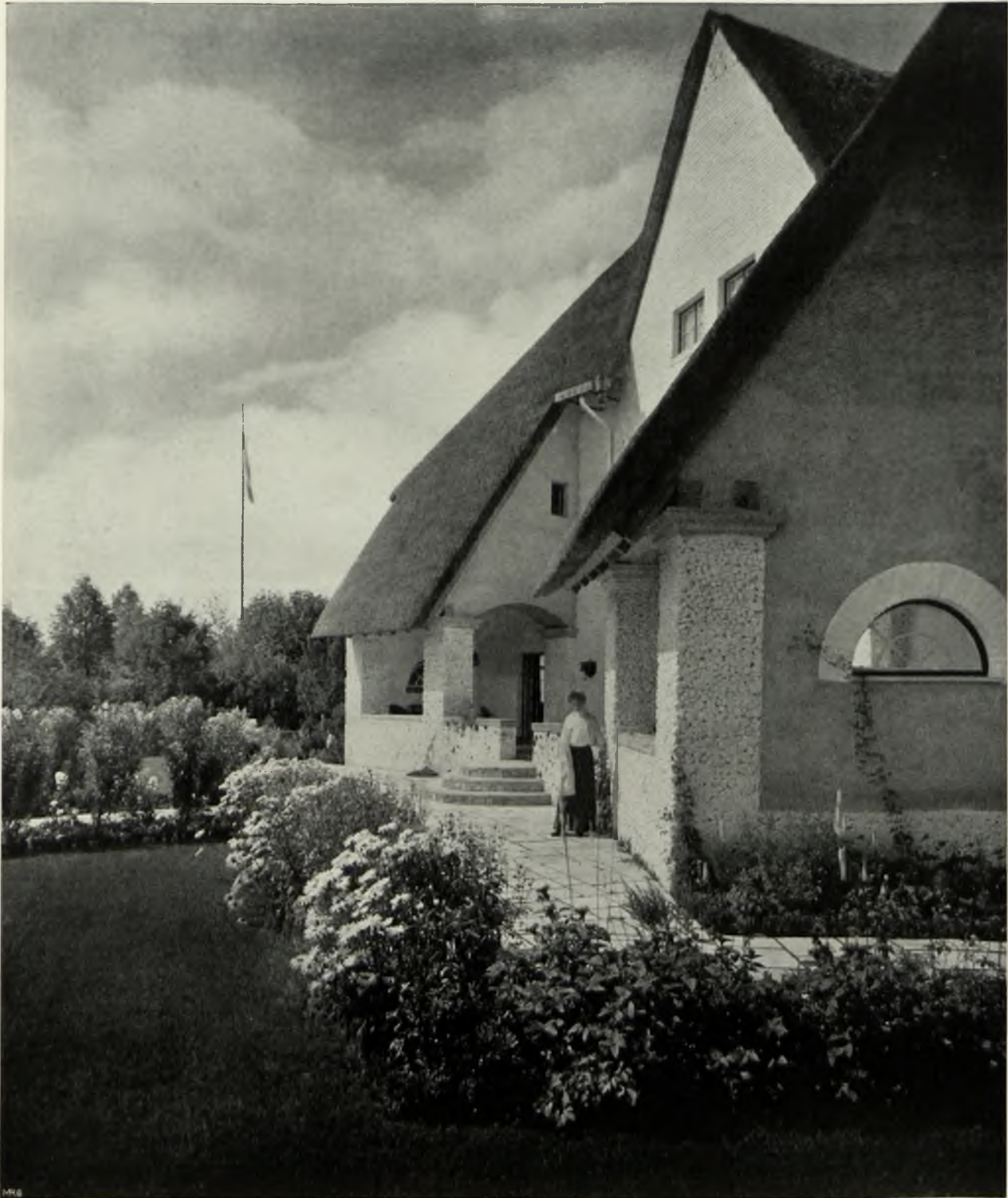
INO A. CAMPBELL U. R. DRACH-MÜNCHEN. GEDECKTE TERRASSE AM LANDHAUS B. LOGGIA, PLATTENWEG U. STAUDENRABATTEN
