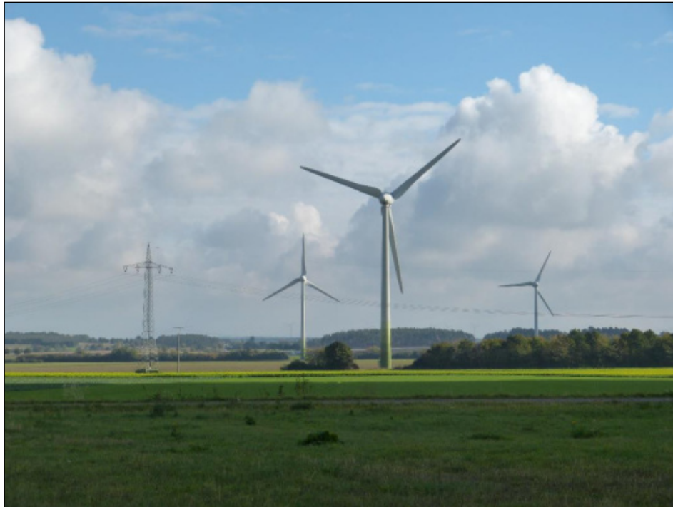
Abb. 2-10: Bestandsanlagen des Windparks Papenrode, im Hintergrund verläuft die 110 kV-Freileitung.
