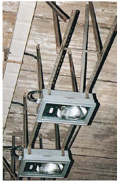
Verkehrstunnel: Unterkonstruktion für Straßenbeleuchtung
