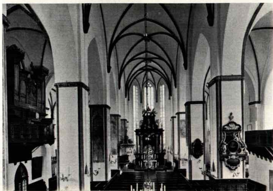
Abb. 1. Inneres nach Osten vor und nach der Instandsetzung. Foto: Wilh. Castelli
