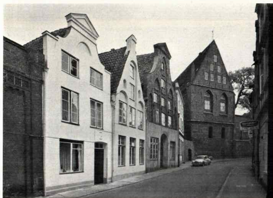
Abb. 5. Kleine Altefähre mit dem Flügelbau des Burgklosters vor und nach der Instandsetzung der Häusergruppe Nr. 12.
