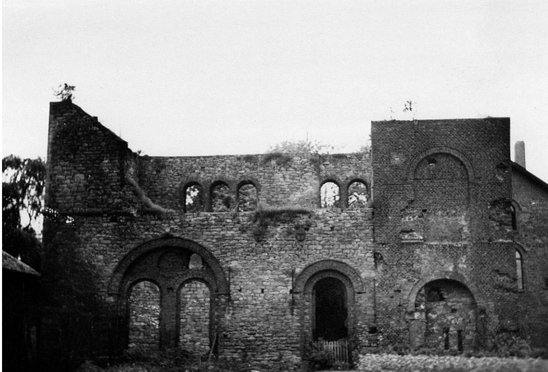
Die Reste des Schachtgebäudes „Rochussen“
