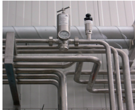
Abb. 3: \text{CO}_2 -Leitung mit Druckminder- und Sicherheitsventil
