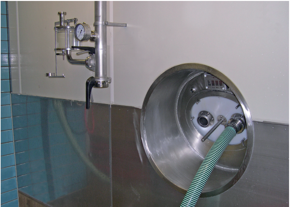
Abb. 7: Beispiel für eine Absaugvorrichtung an einem Lagertank mit Belüftung über Spundapparaturleitung und Mannlochöffnung
