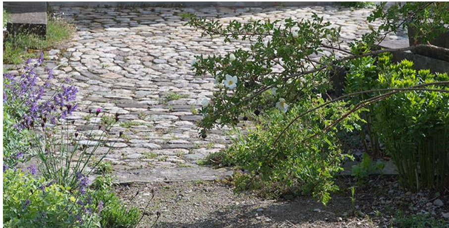
Abb. 9: Gepflasterter Zugangsweg, 10 Jahre nach der Erstellung [16]
